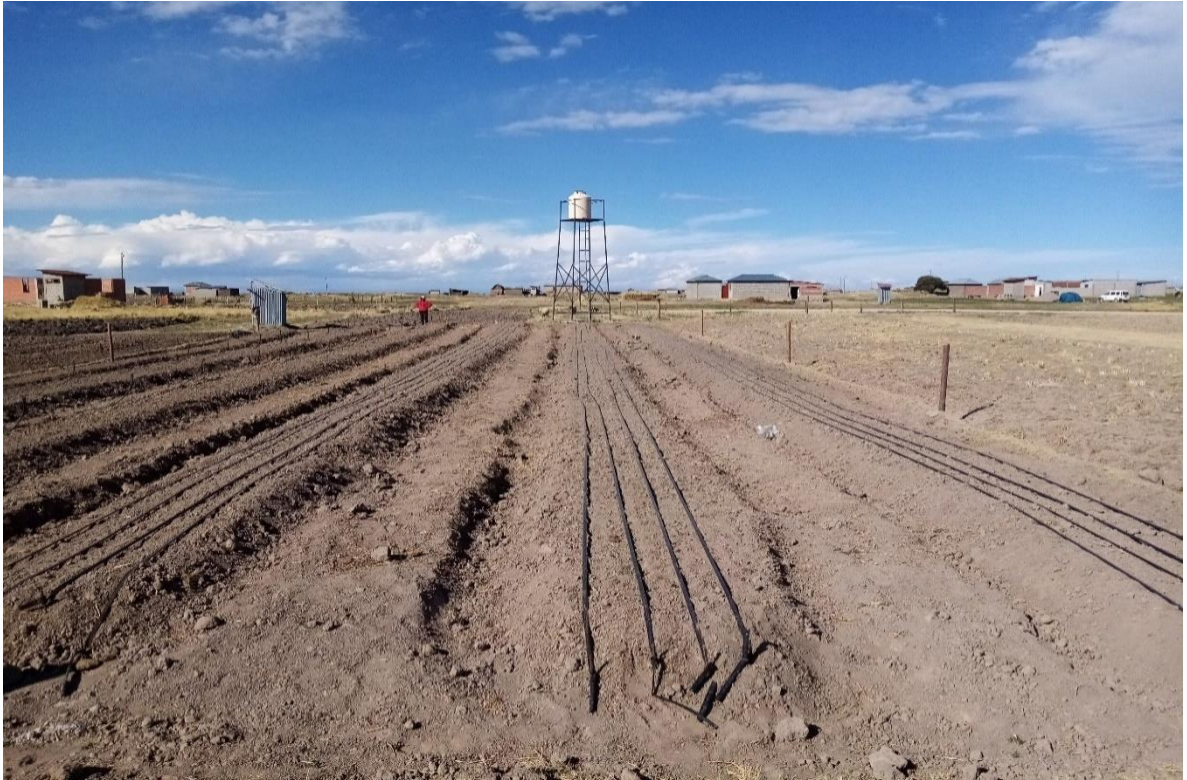
Foto 05. Instalación del sistema de riego por goteo – Bloques (A1, A2 y A3)
