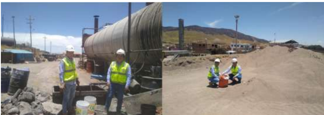
Fotografía 01: Obtención de agregados y cemento asfáltico.
