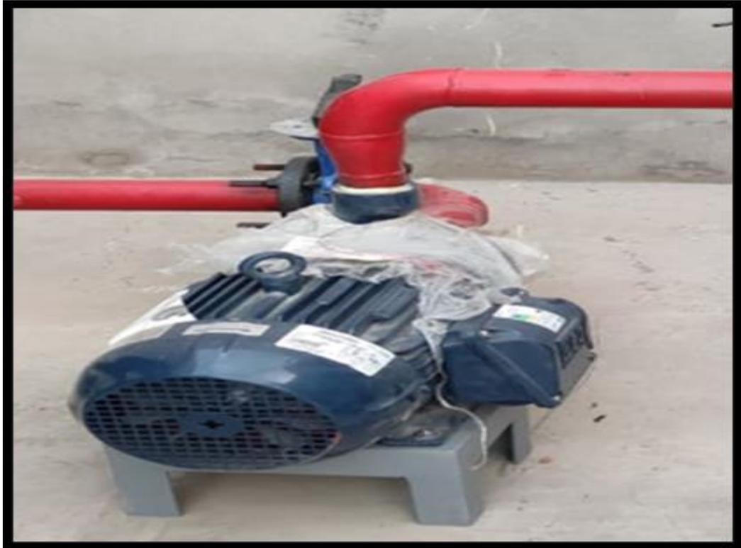
**Figura 33.** Bomba de Solución Continuo
