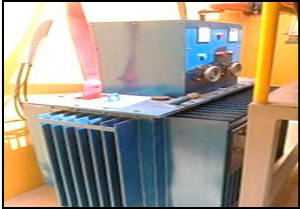
*Figura 38.* Rectificador de corriente 2500 A
