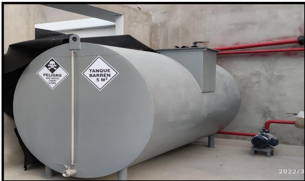
*Figura 31.* Tanque de solución barren
