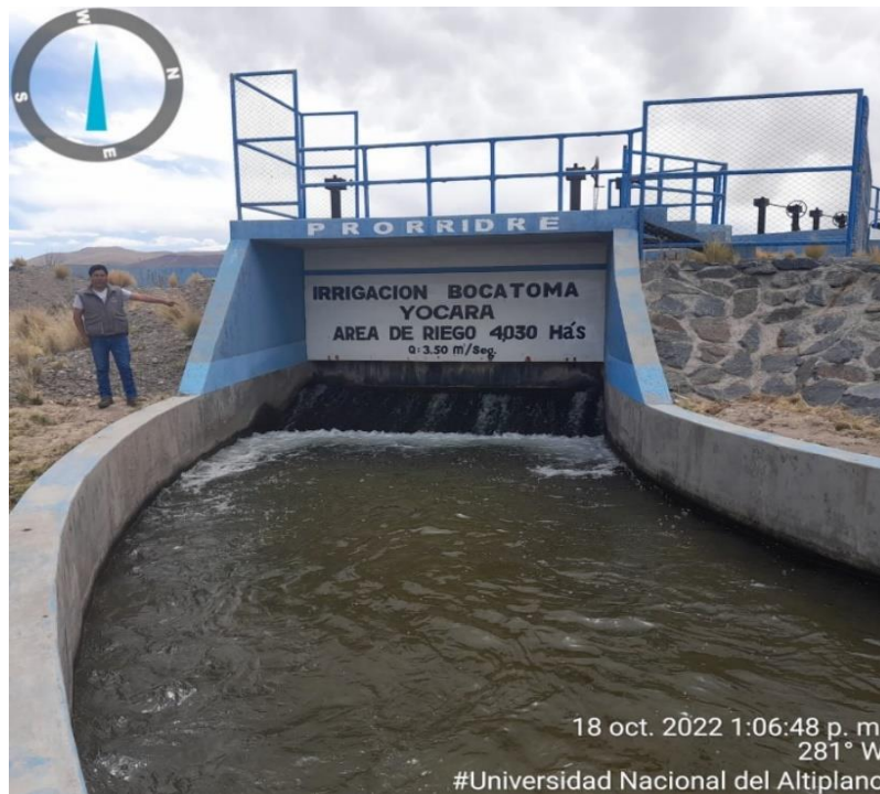
Figura 15. Reconocimiento del Punto 1 en la Bocatoma Principal
