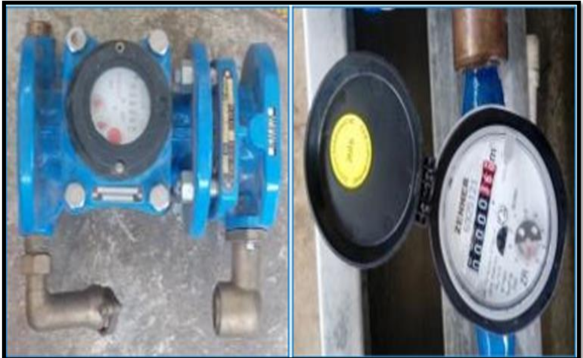
FOTOGRAFÍA 10: Medidores para grandes consumidores, y a la derecha uno para pequeños
