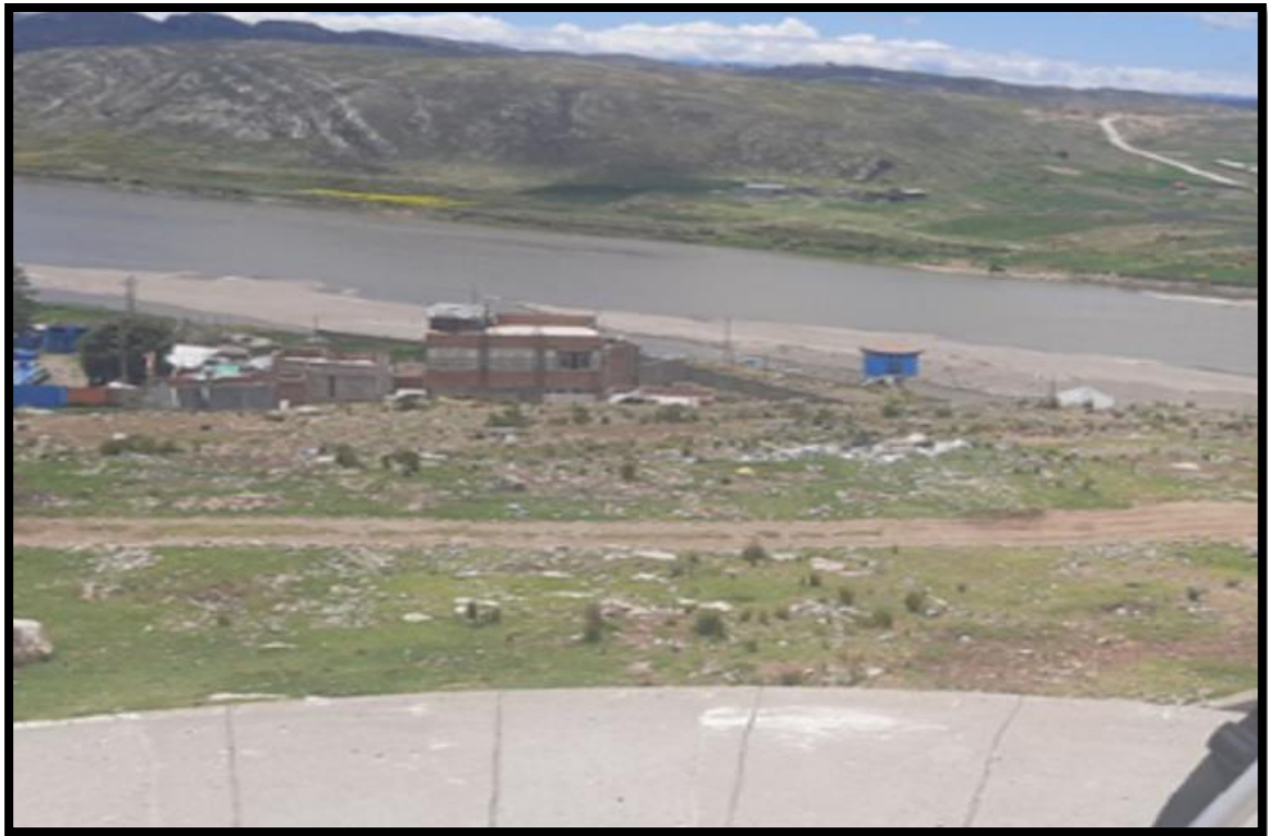
FOTOGRAFÍA 5: Línea de impulsión de agua potable de captación subterránea “Churupampa” al reservorio Campanani
