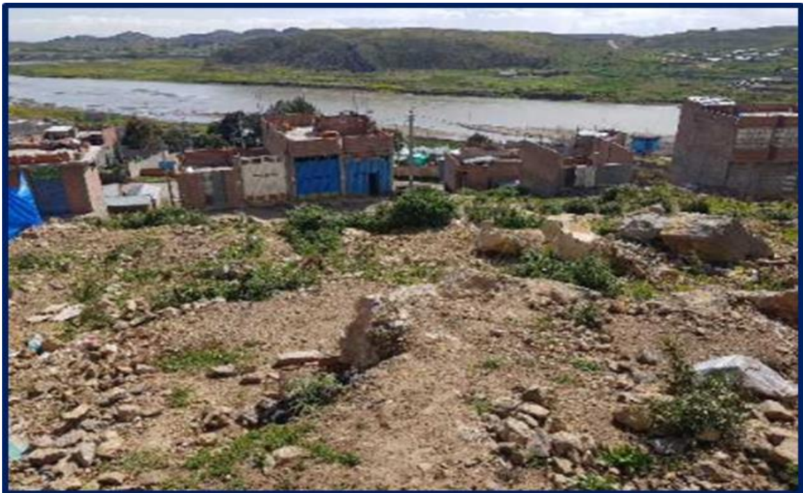
FOTOGRAFÍA 4: Captación proyectada y como punto de descarga final el reservorio Santa Barbara
