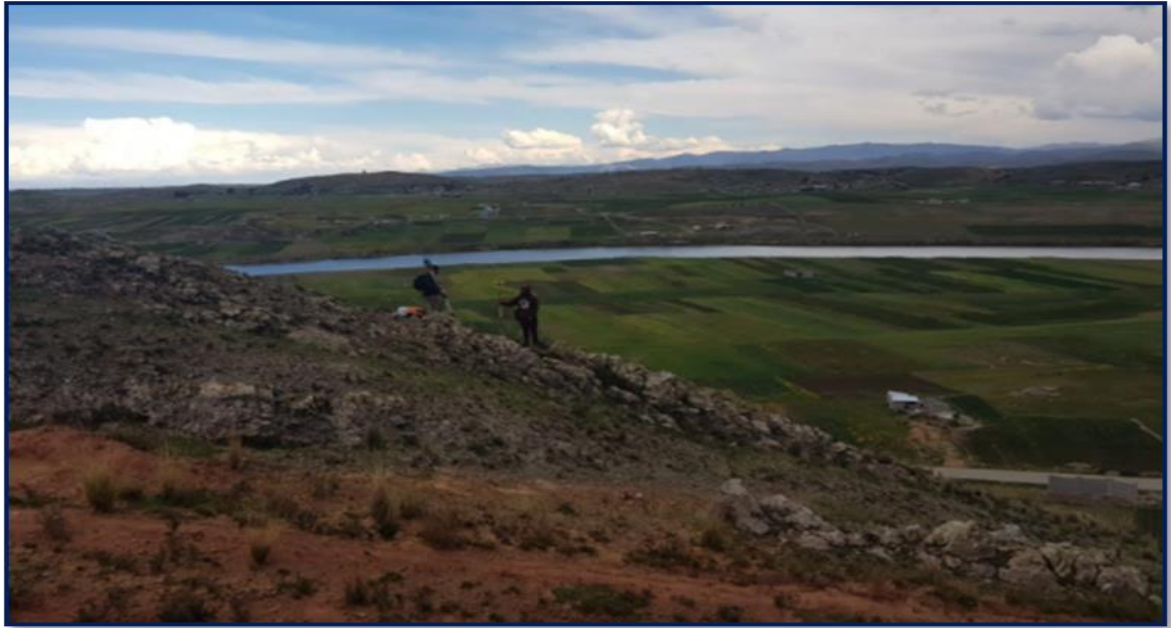
FOTOGRAFÍA 7: Línea de impulsión de captación subterránea “Puente Internacional”
