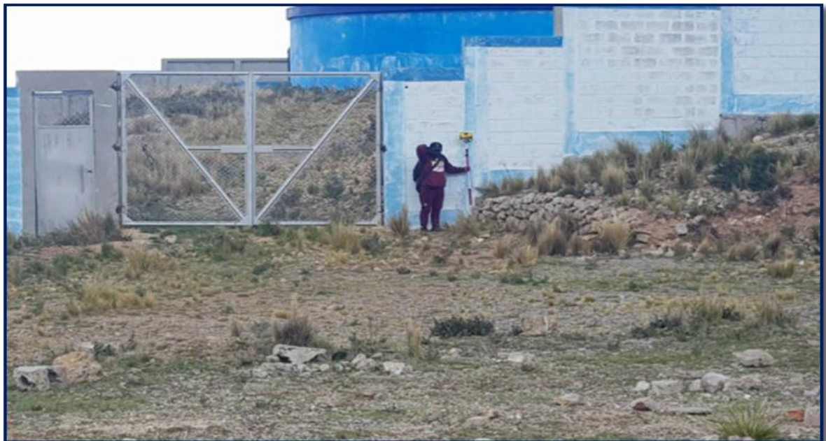
FOTOGRAFÍA 6: Línea de impulsión tiene como inicio la captación subterránea (Pozo tubular) “Churupampa”
