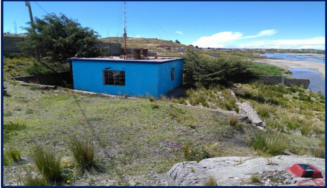
FOTOGRAFÍA 1: Sistema de captación de agua potable para la ciudad de Ilave
