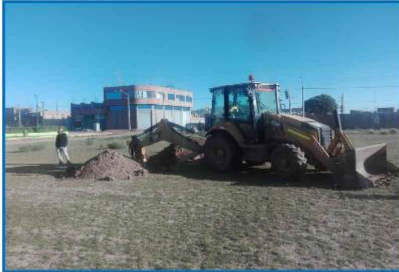
Figura 15. Excavación de calicata.
