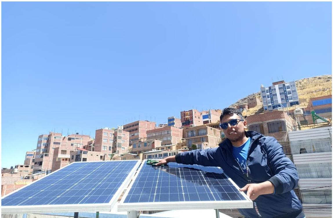
Instalación de los módulos fotovoltaicos de 120 W.
