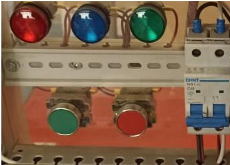
**Figura 17:** Interruptor termomagnético, indicadores luminosos y pulsadores
