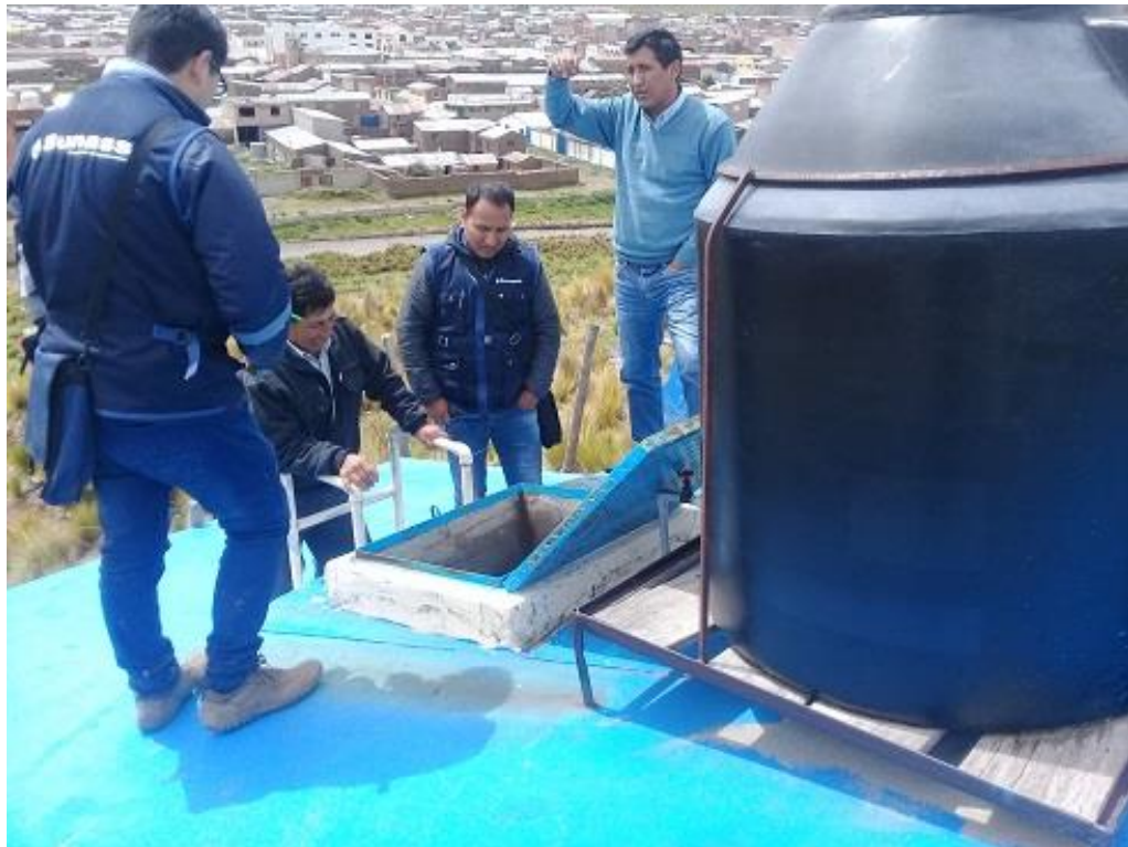
Figura 50: Supervision de niveles de tratamiento de agua Elaborado por el equipo de trabajo
