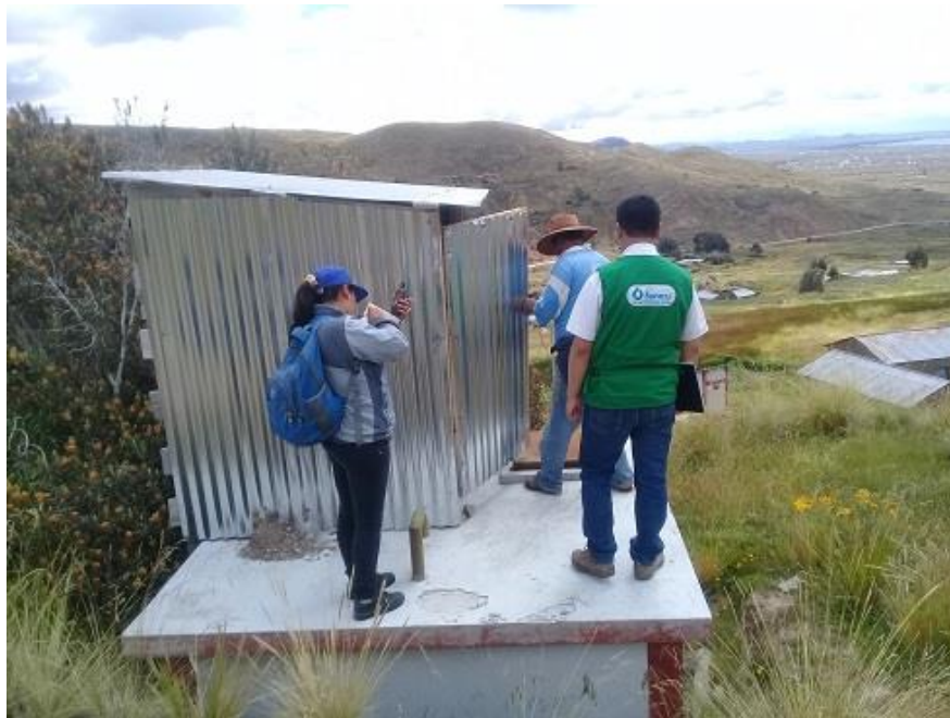
Figura 44: Reservorio de agua Juli Elaborado por el equipo de trabajo
