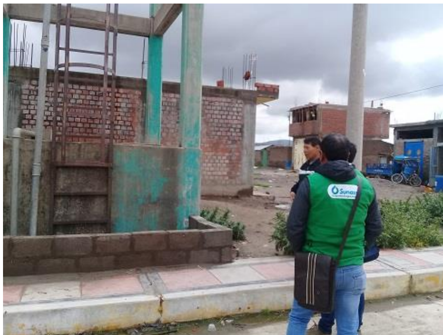
Figura 38: Escalera de reservorio Elaborado por el equipo de trabajo
