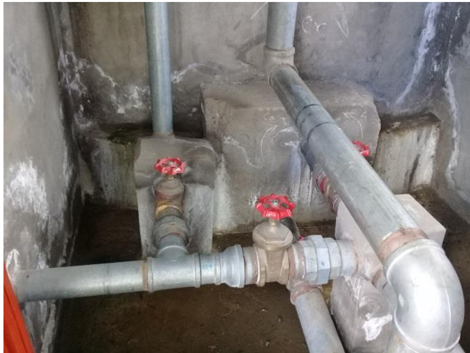
Figura 23: Tuberías del sistema de almacenamiento de agua Elaborado por el equipo de trabajo
