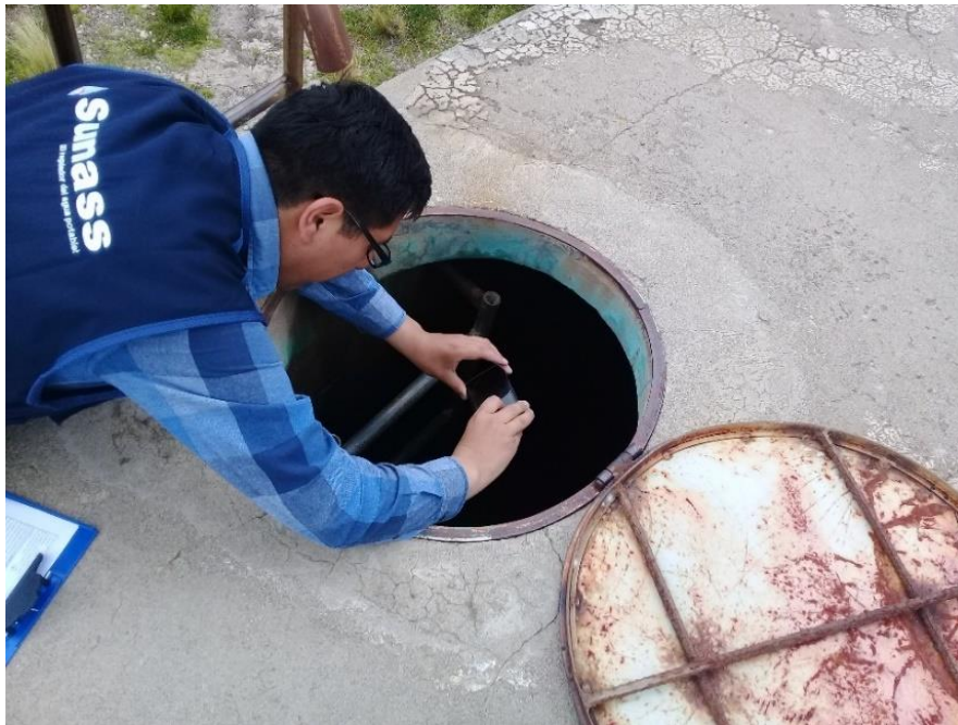
Figura 27: Almacén o tanque de agua Elaborado por el equipo de trabajo
