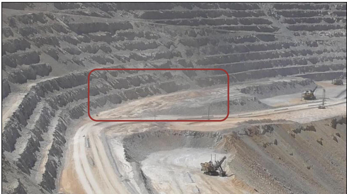
Figura 2.4: Vista post disparo del proyecto 3190 – 180 y 179.
