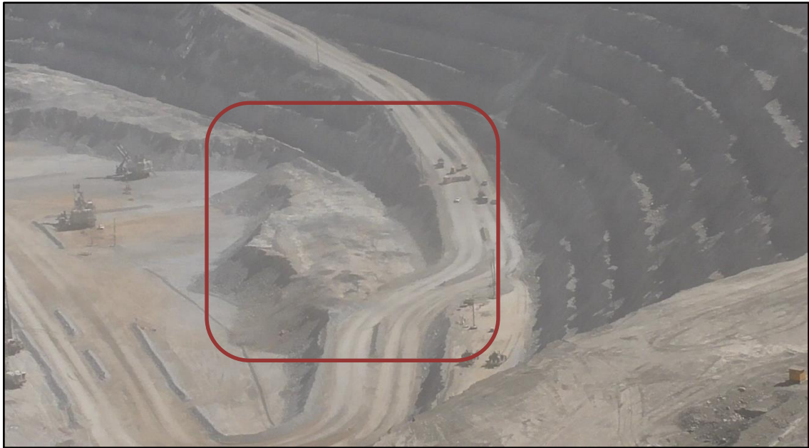
Figura 2.3: Vista post disparo del proyecto 3235 – 201 y 207.
