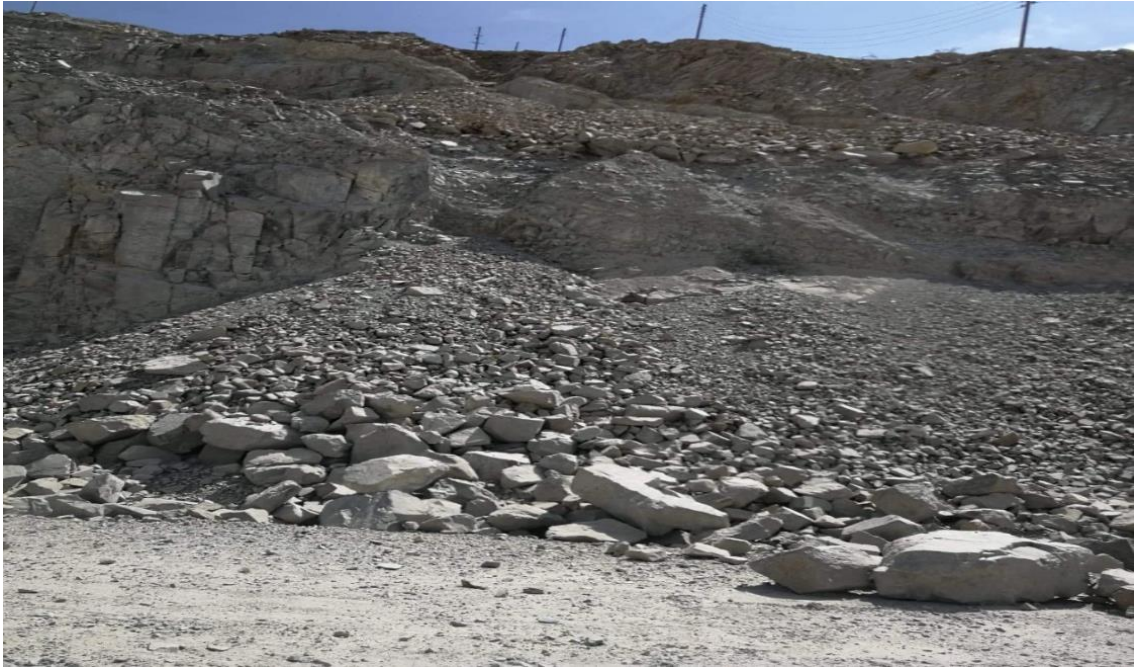
Figura 41. Vista de las paredes de banco de un disparo en fase 5 sin voladura controlada.
