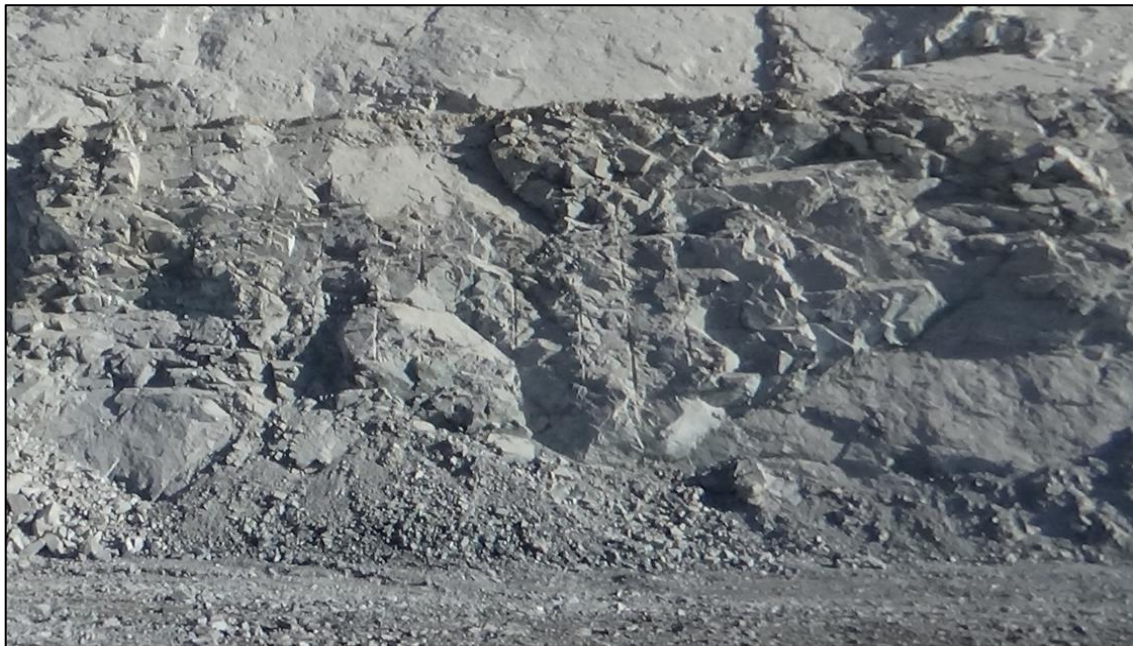
Figura 38. Vista de las paredes de banco del disparo 3235 – 201 y 207 con voladura controlada.
