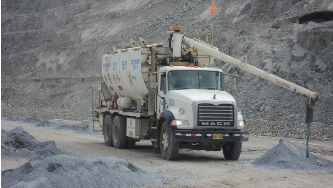
Figura 23. Carguío de los taladros de recorte con el agente explosivo Quantex 73.
