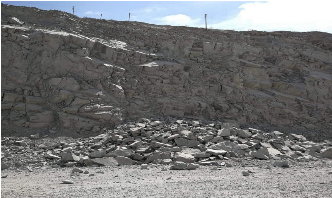
Figura 40. Vista de las paredes de banco de otro disparo en fase 4 sin voladura controlada.
