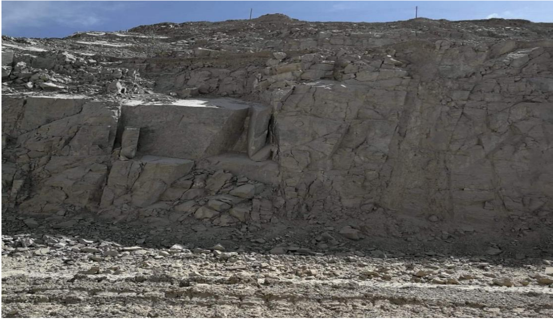
Figura 39. Vista de las paredes de banco de un disparo en fase 4 sin voladura controlada.
