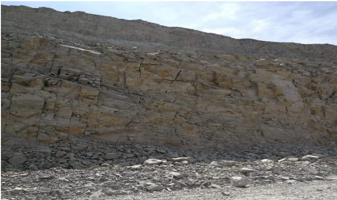
Figura 42. Vista de las paredes de banco de otro disparo en fase 5 sin voladura controlada.
