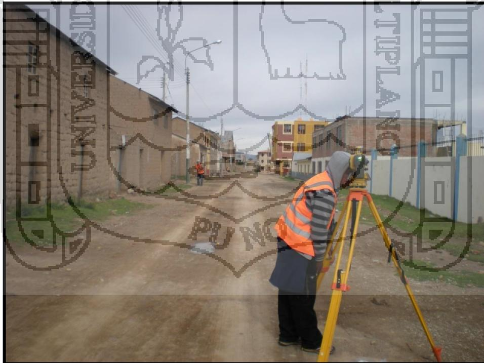
**Figura N° 04.2:** Vistas del Levantamiento Topográfico con Estación Total en la Avenida Simón Bolívar.
