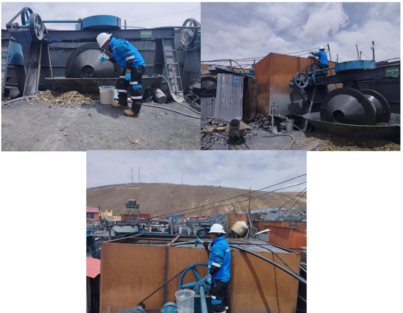
Figura B-9: Neutralización de DAM en tanque a nivel de Planta en el Sector Antahuila,
