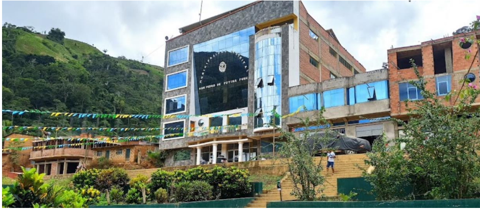
Figura 4. 77: Construcción del lugar
