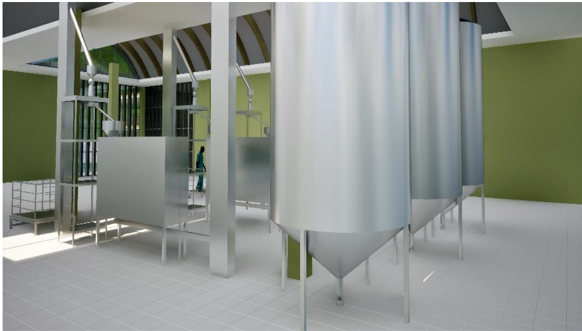
Figura 4. 126: Vista del interior de la planta de producción
