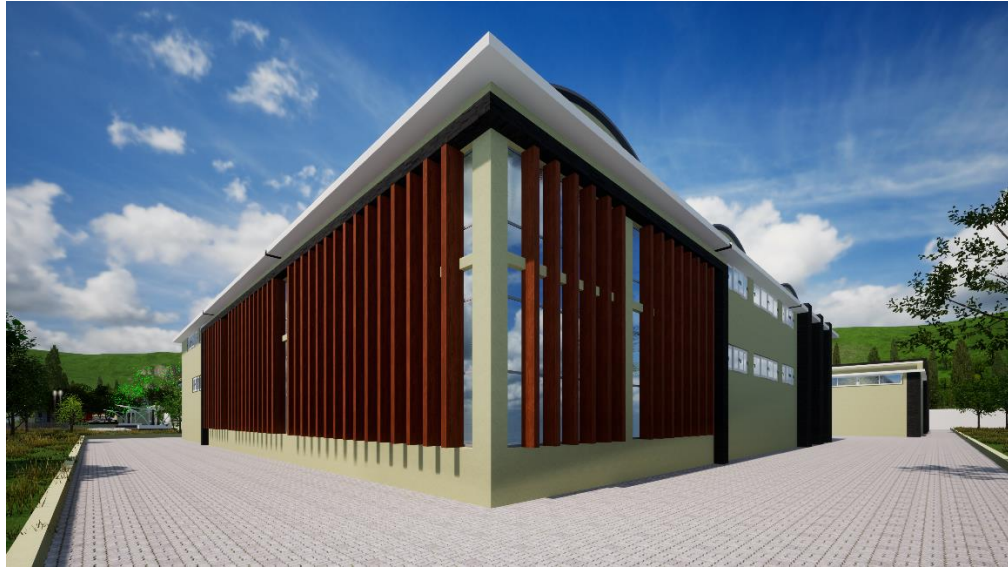
Figura 4. 120: Vista del centro de capacitación- ventanas con Lamas de protección solar.
