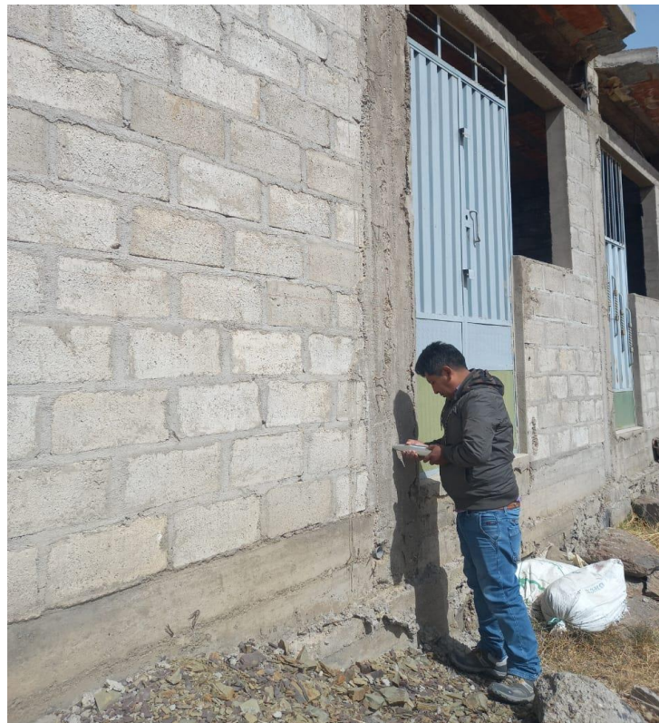
Figura A. 16 Medición de la resistencia del concreto en columnas en la vivienda V-21, realizado en la fecha 12/05/22
