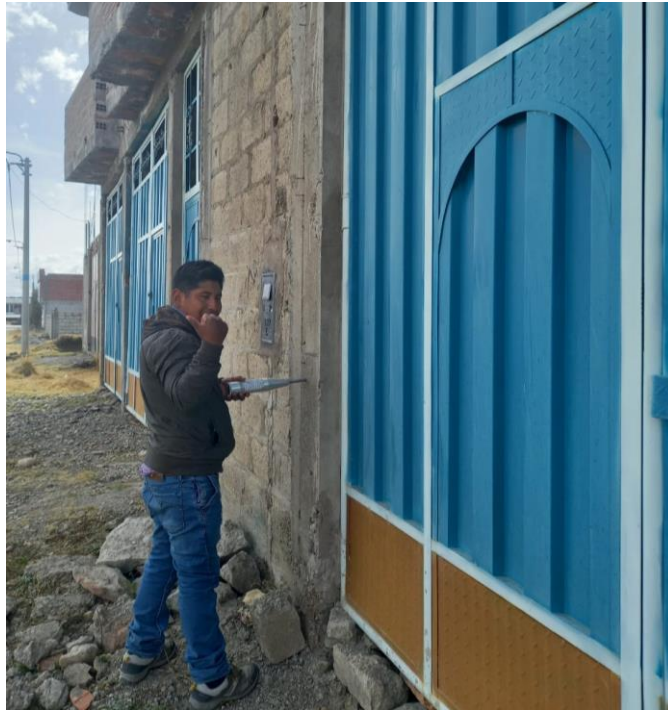
Figura A. 15 Medición de la resistencia del concreto en columnas en la vivienda V-13, realizado en la fecha 12/05/22
