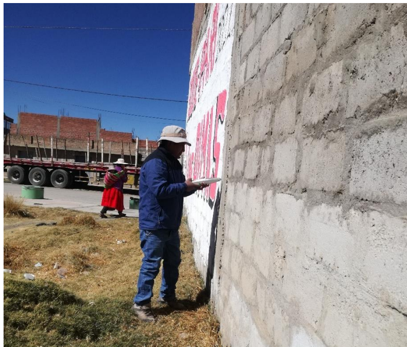
Figura A. 14 Medición de la resistencia del concreto en columnas en la vivienda V-12, realizado en la fecha 15/05/22
