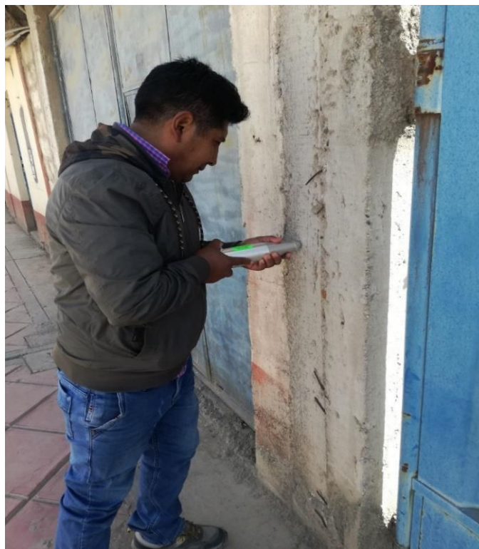
Figura A. 12 Medición de la resistencia del concreto en columnas en la vivienda V-37, realizado en la fecha 12/05/22
