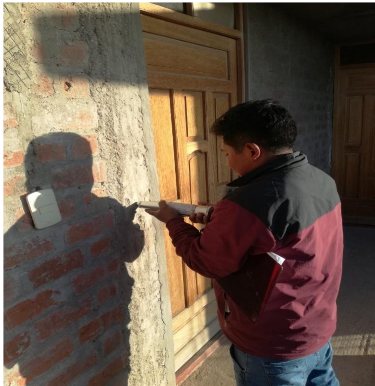
Figura A. 9 Medición de la resistencia del concreto en columnas en la vivienda V-50, realizado en la fecha 09/05/22
