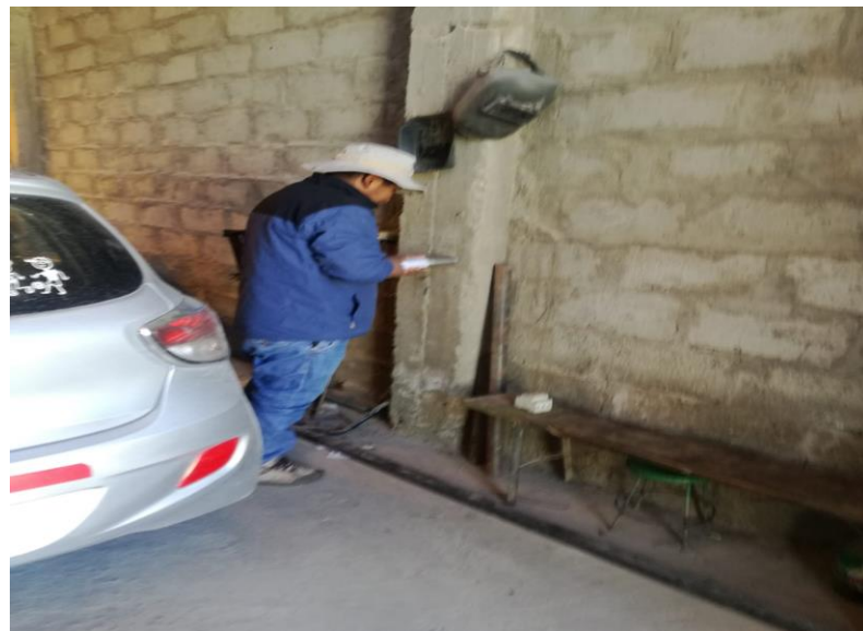
Figura 16: Medición de la resistencia del concreto en columnas de la vivienda V-23 Fuente: Elaborado por el equipo de trabajo en la fecha 15/05/2022
