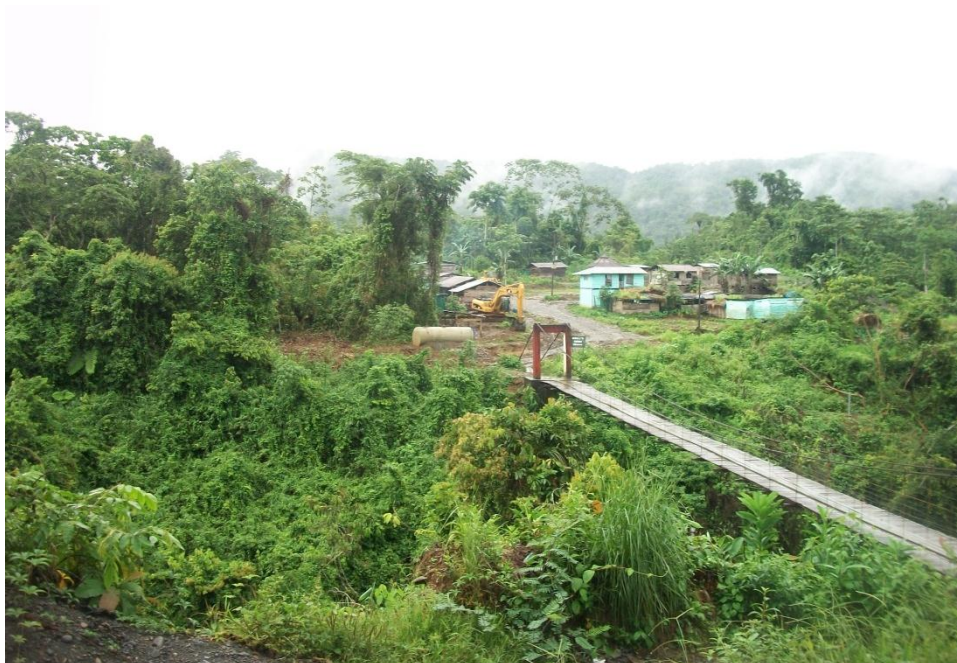
Campamento minero boca San gabán
