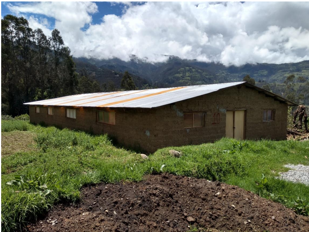
Figura 6. Infraestructura para la crianza de cuyes
