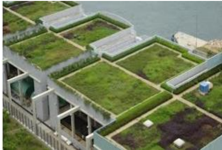
Figura 1. Sistema de cubierta o techos verdes
