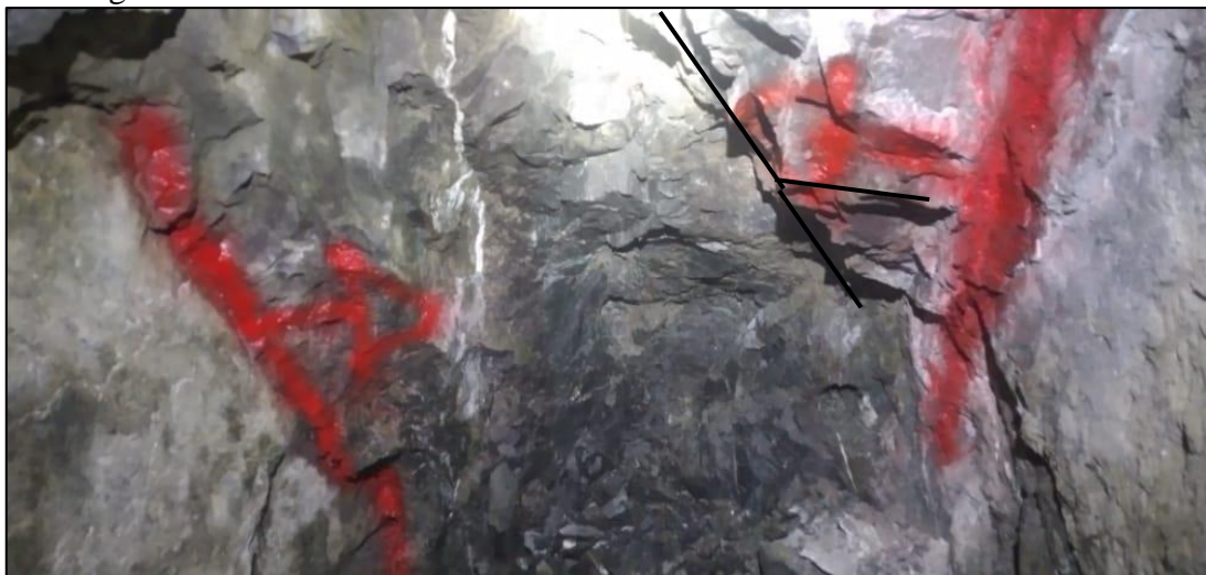
Foto 3. Se muestra cuñas en el techo como se observa de manera estable en la excavación subterránea.
