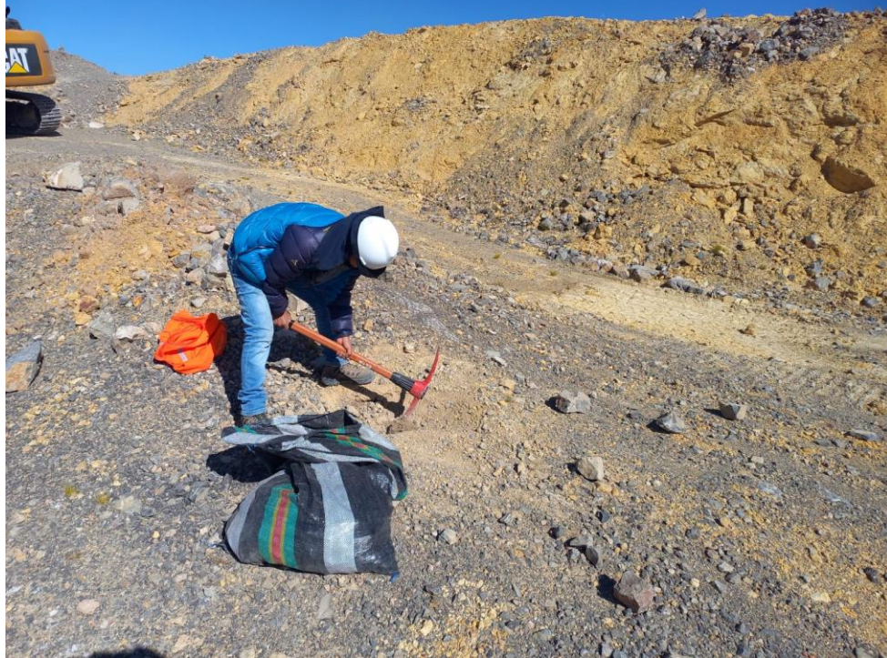
Fotografía 3: Se realiza el muestreo en la calicata C3.
