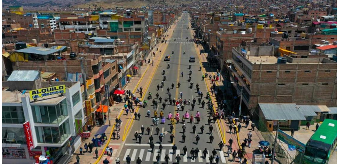
Figura 62. Av. Simon Bolivar- Cableado Subterráneo en Puno, Perú.
