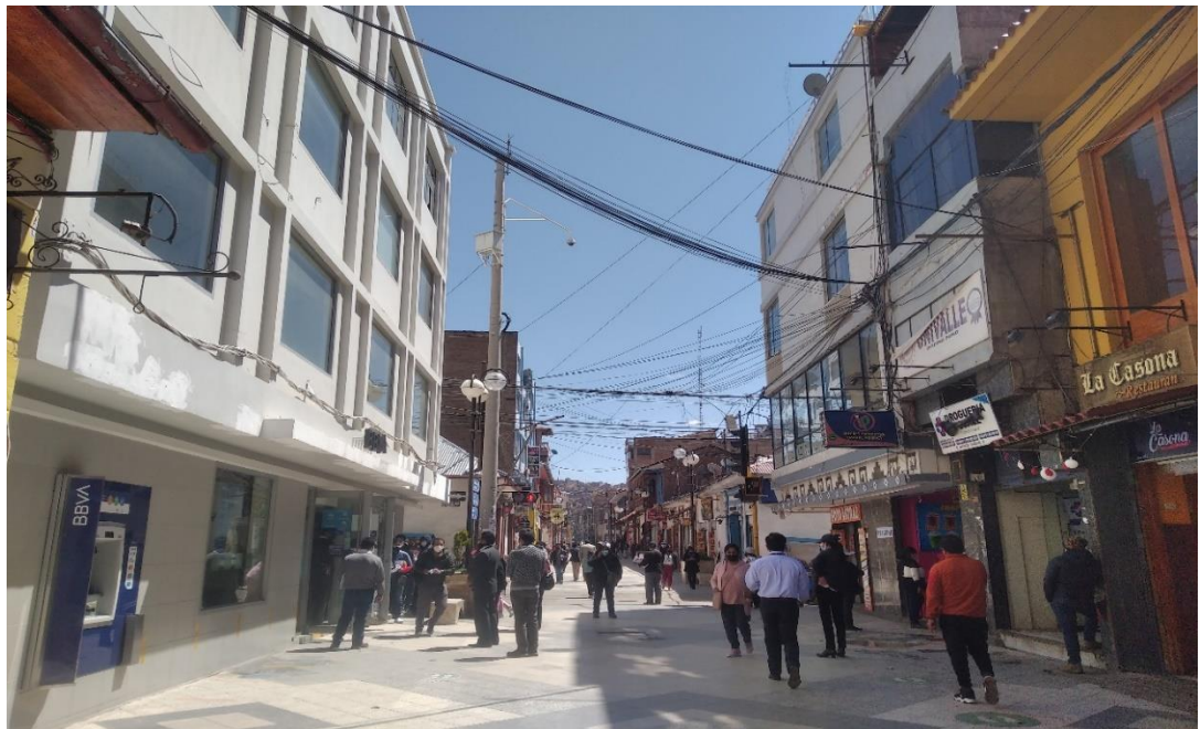
Figura 63. Jr. Lima, Cableado Aéreo en Puno, Perú.
