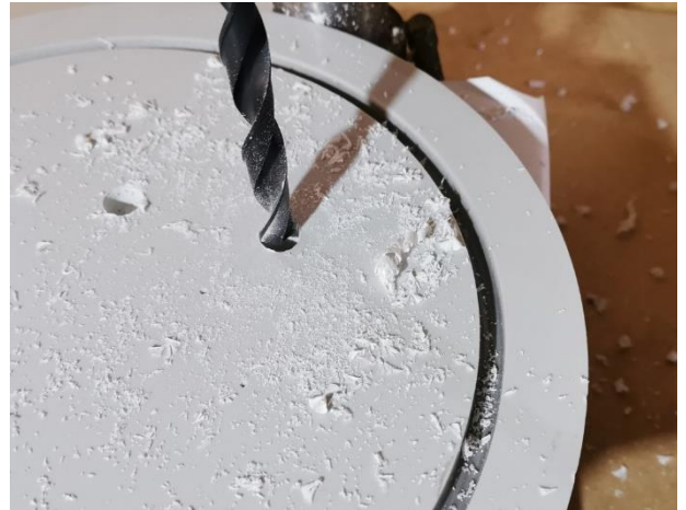
Figura 41. Perforación de la tapa mediante taladro de mesa
