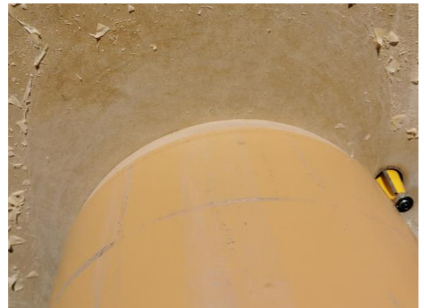
Figura 37. Formación de bisel con fresa de corte con inclinación de 11.25°
