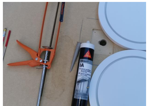
Figura 39. Formación de empaque de silicona en el canal de la tapa (cara interna)
