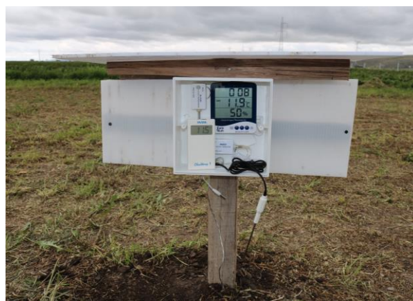
Figura 33. Instalación de dispositivos para control de temperatura y humedad
