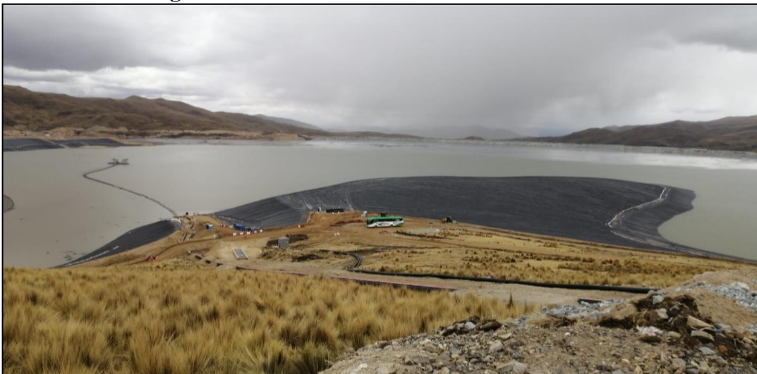
Figura 15: Ubicación de motores de media tensión
