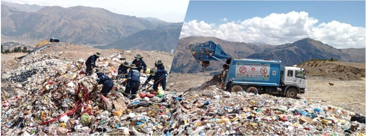
Figura 15. Vista de la disposición final de los residuos sólidos
