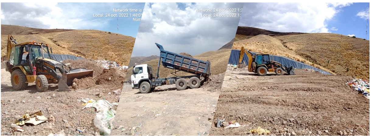
Figura 16. Vista del transporte de material de relleno
