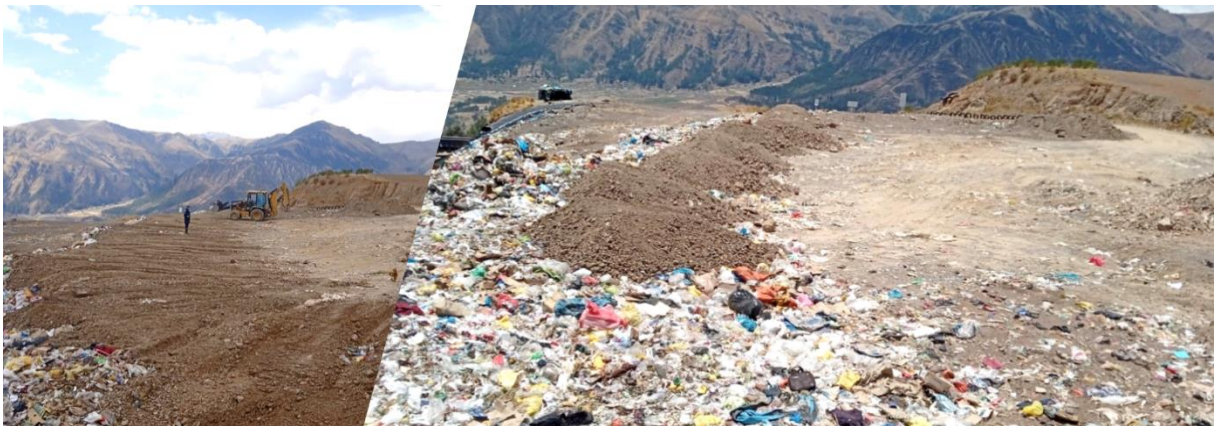
Figura 17. Vista del recubrimiento/tapado de los residuos sólidos
