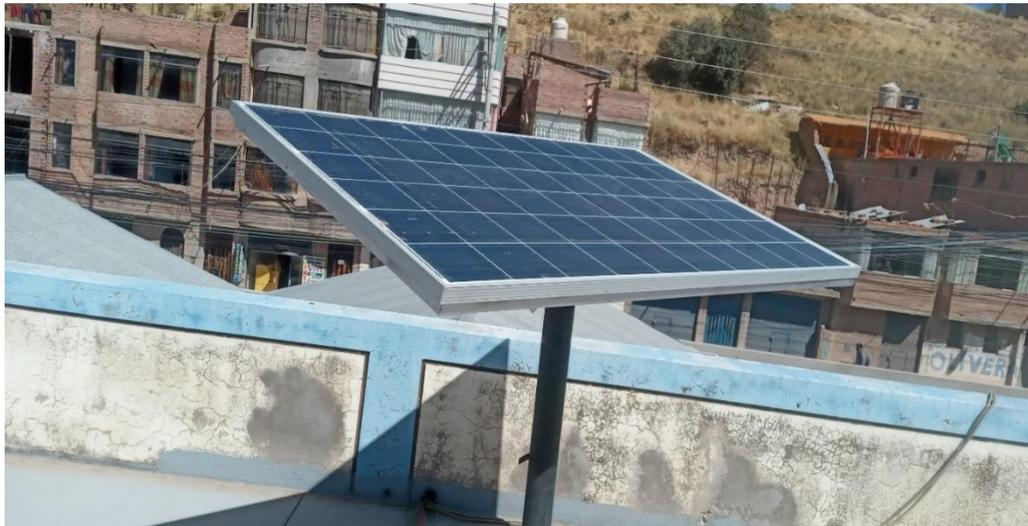
**Figura 19:** Módulo fotovoltaico de 270 W instalado en la EPIME.
