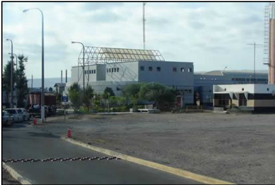
Figura 8. Ingreso para el respectivo control de mercancías en el complejo de Tomasiri.
