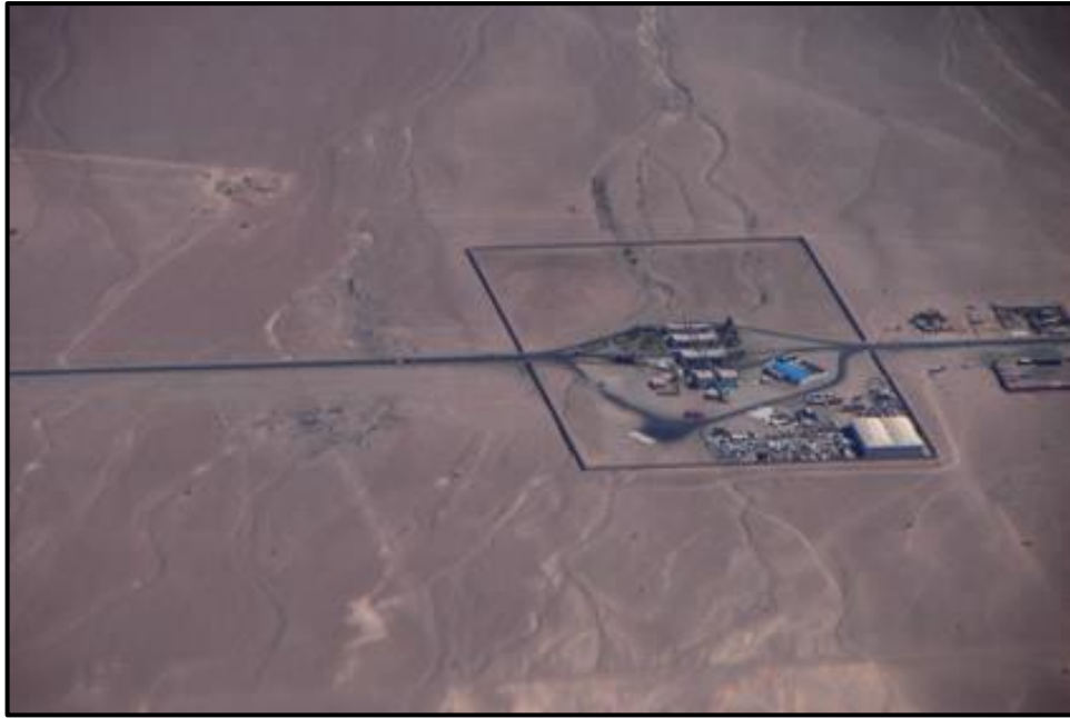
Figura 7. Vista Aérea del Complejo Aduanero de Tomasiri, Tacna.
