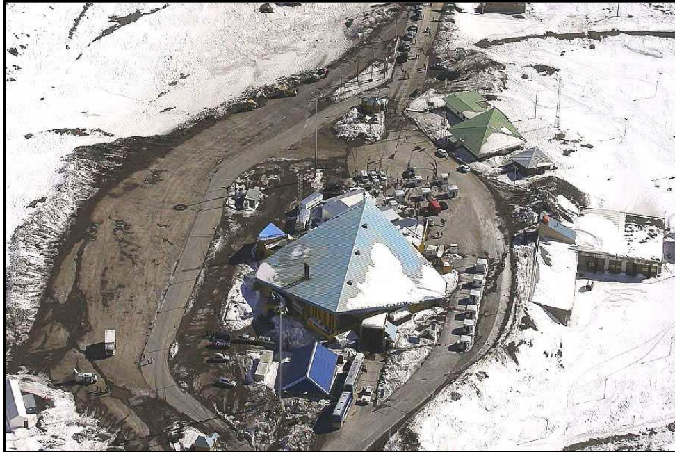
Figura 5. Vista Aérea del Complejo Aduanero Los Libertadores
