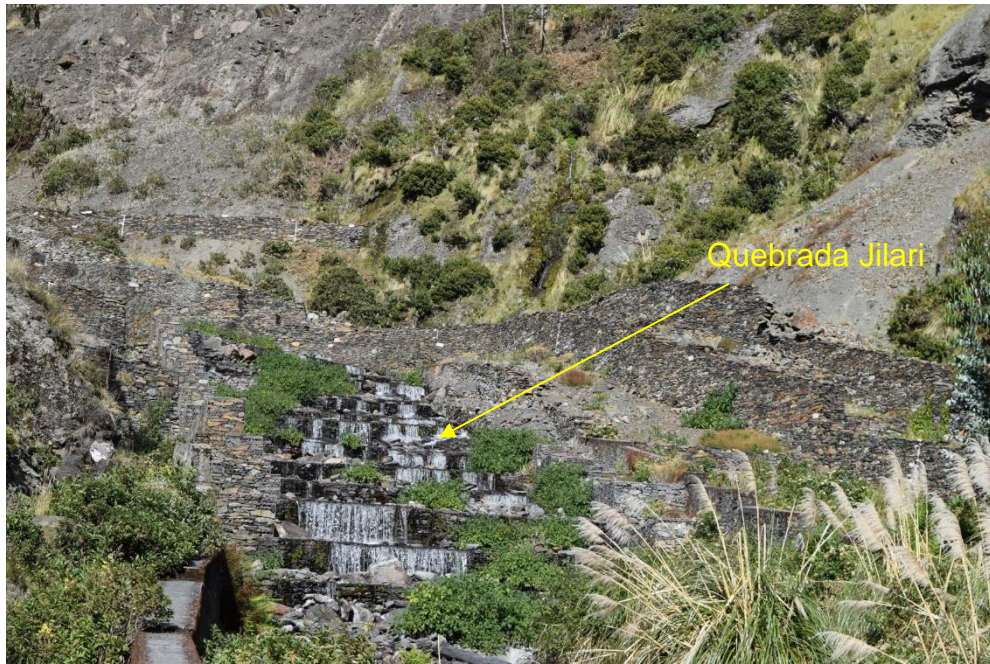
Figura 31. Diques para control de erosión en quebrada Jilari (Dic. 2015).
