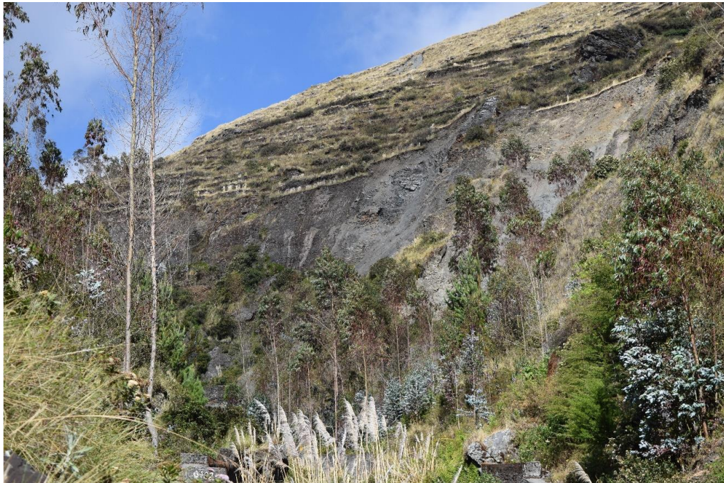
Figura 25. Zona de un deslizamiento rotacional, quebrada Jilari.
