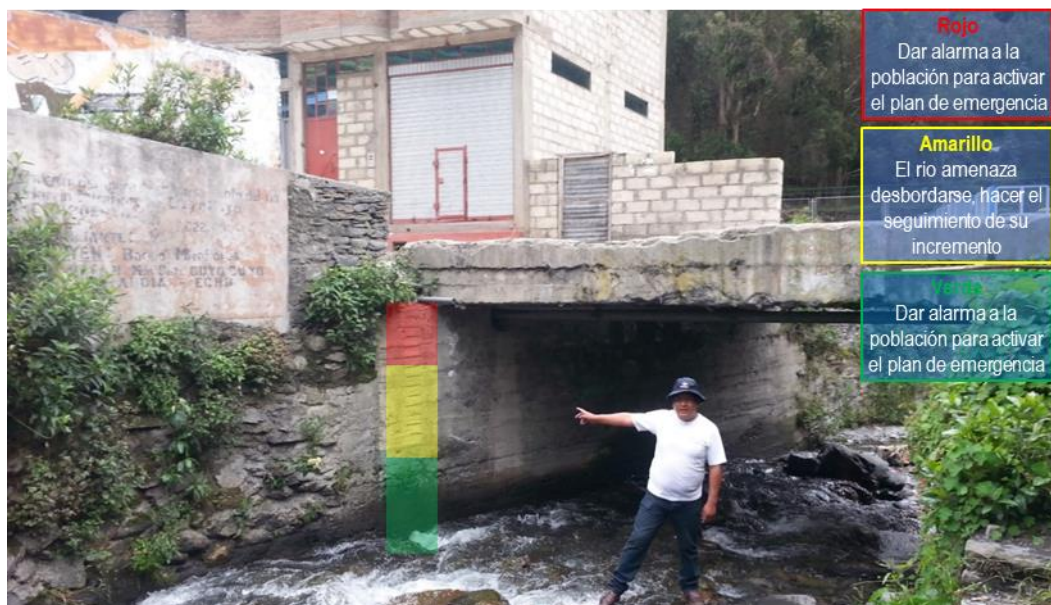
Figura 24. Quebrada Jilari en la ciudad de Cuyocuyo, se observan niveles de alerta.
