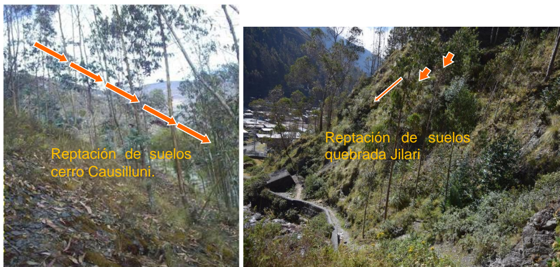
Figura 27. Zonas reptación de los suelos, quebrada Jilari (Quispe, 2008).
