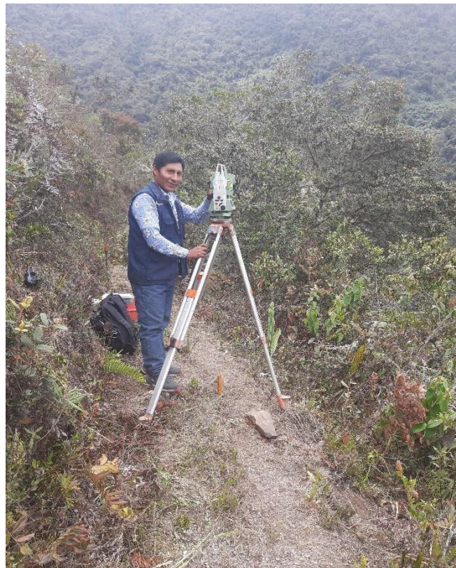
Trazo y replanteo conducción
