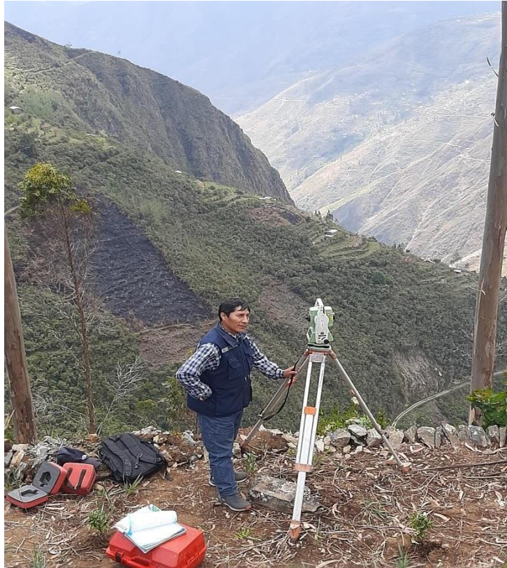
Trazo y replanteo distribución
