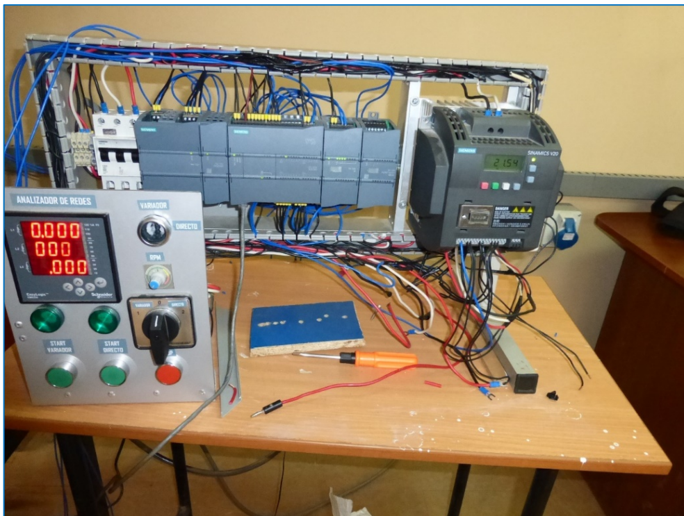
Anexo 2. Módulo de control PLC S71200 para implementar el PID y el variador
