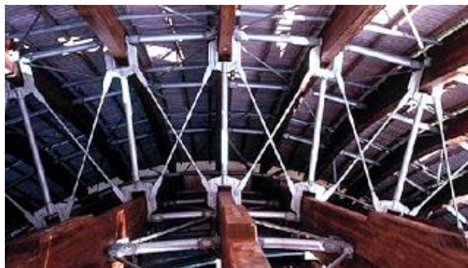
Figura 13: Estructura en techos con madera iroko y acero inoxidable Fuente: www.archdaily.com
