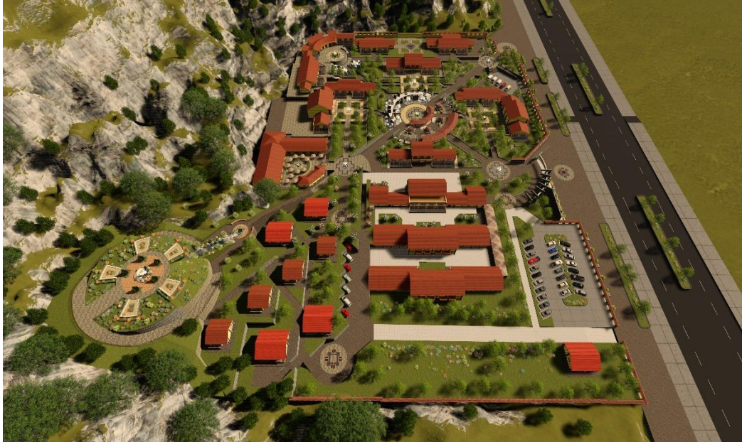
Figura 134: Vista lateral general del proyecto
