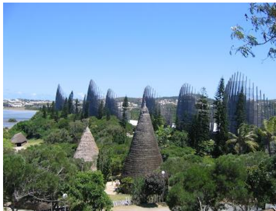
Figura 15: Vista del conjunto Fuente: www.archdaily.com
