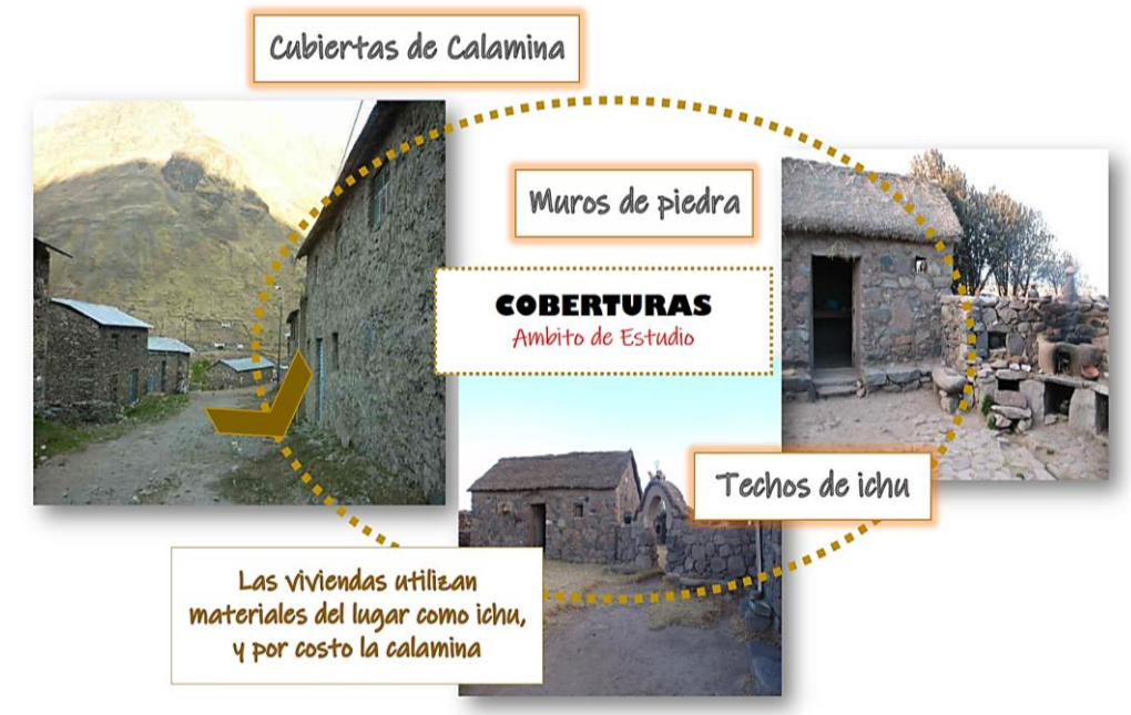
Figura 32: Coberturas Fuente: Elaborado por el equipo de trabajo
