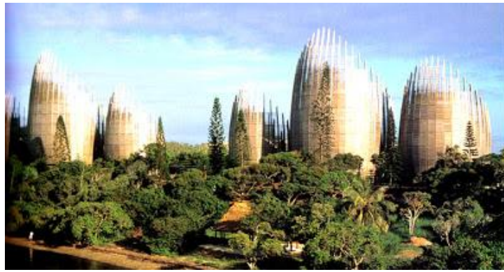
Figura 5: Vista exterior del complejo Fuente: www.archdaily.com
