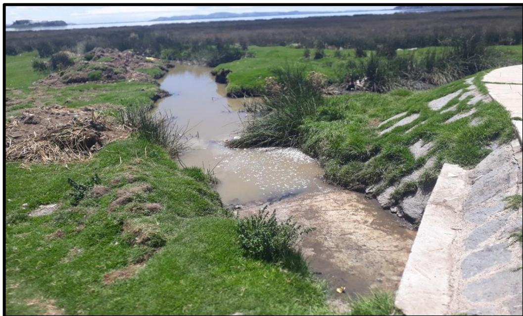
Figura 27. Desemboque de agua fluvial, Av. Costanera Sur con Jr. Ricardo Palma
