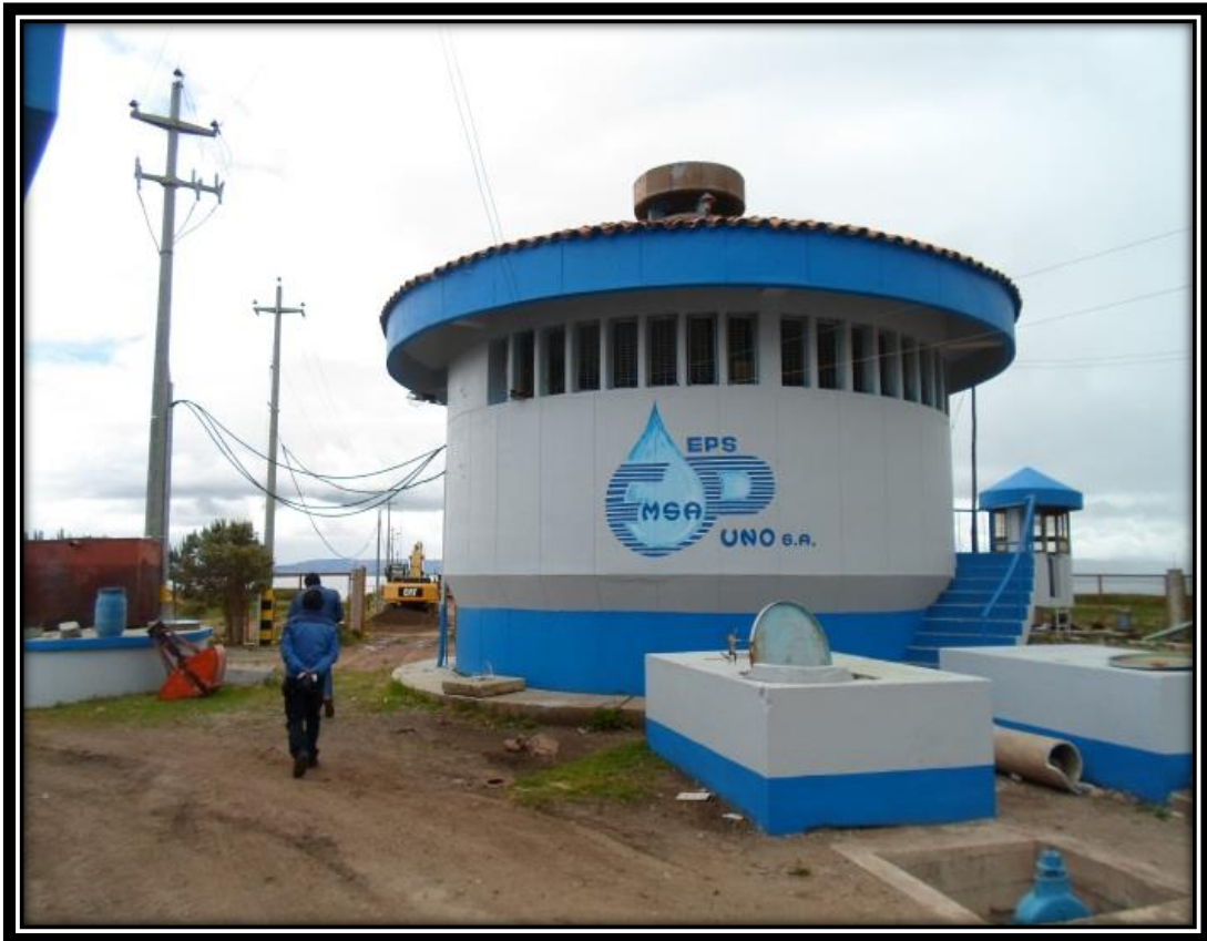
Figura 16. Planta de tratamiento – Chimu
