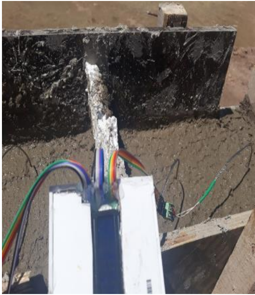
Fotografía 17. Instalación de los cuatro sensores de temperatura en obra
