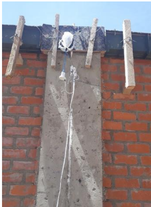
Fotografía 19. Ubicación de los sensores de temperatura en las dos uniones viga-columna de confinamiento.
