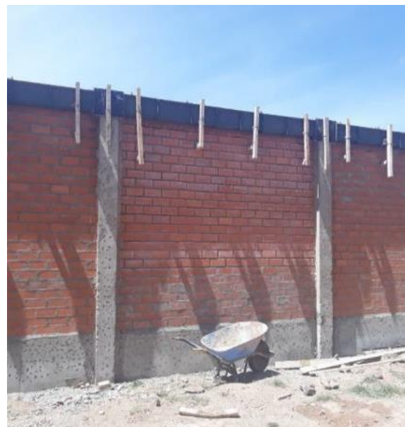
Fotografía 16. Vaciado de concreto en las vigas del cerco perimétrico
