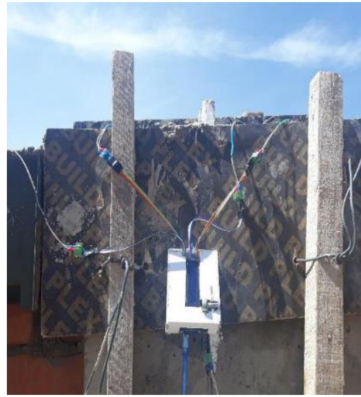
Fotografía 18. Conexión de los sensores de temperatura al módulo de registro de temperaturas en obra
