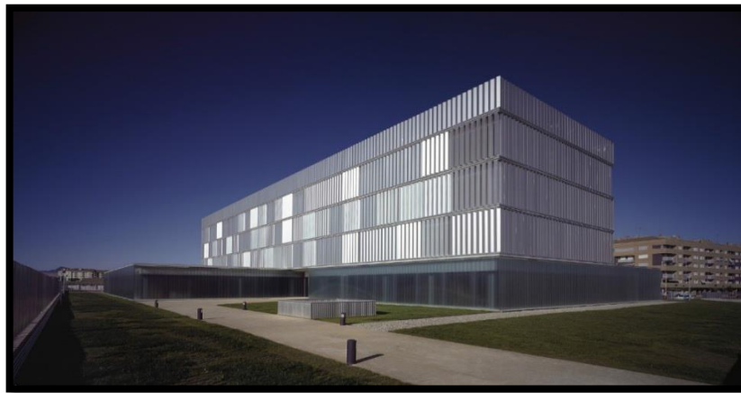
Vista externa de espacios abiertos y cerrados
