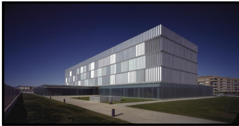
Vista externa de espacios abiertos y cerrados
