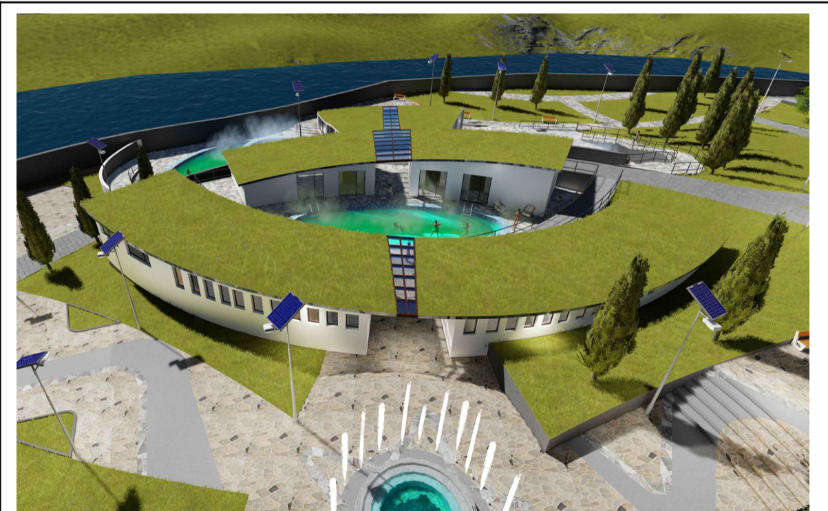
MODULO DE TRATAMIENTO
