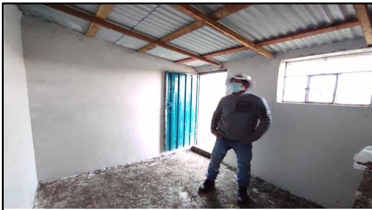
Fotografía 57. VISTA FINAL DEL ENLUCIDO CON YESO
