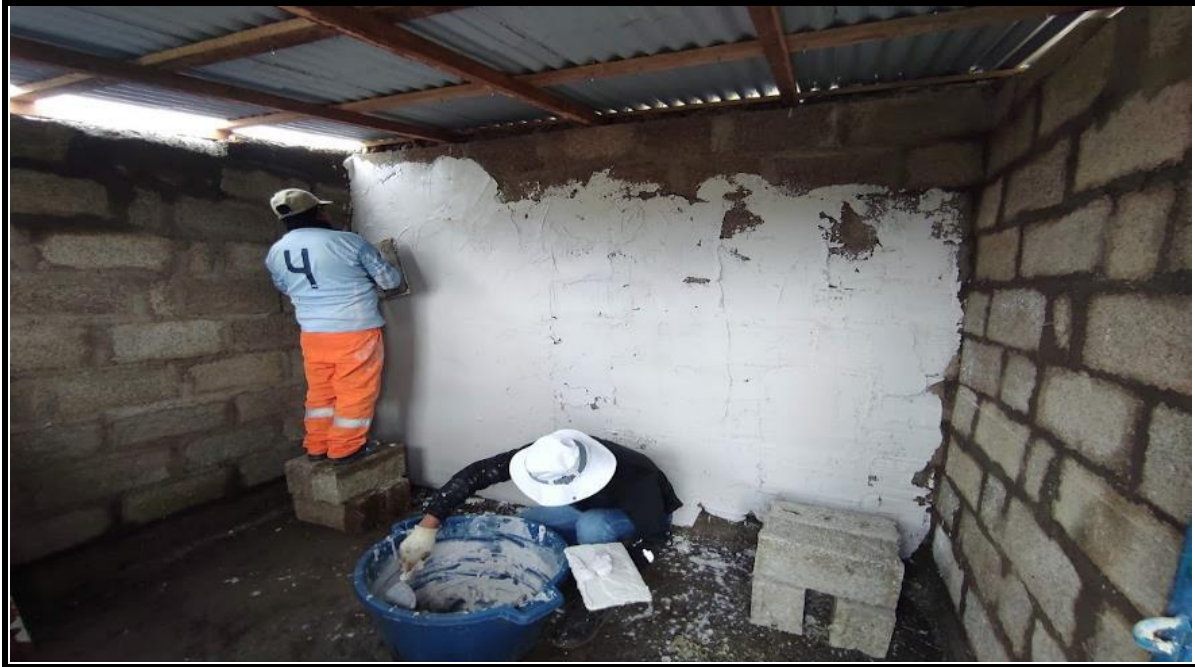
Fotografía 55. VISTA DEL ENLUCIDO DE LOS MUROS INTERIORES
