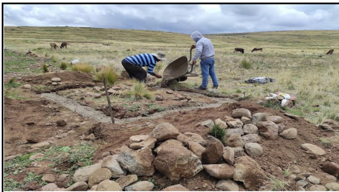
Fotografía 47. VISTA DEL VACIADO DEL CIMIENTO CORRIDO
