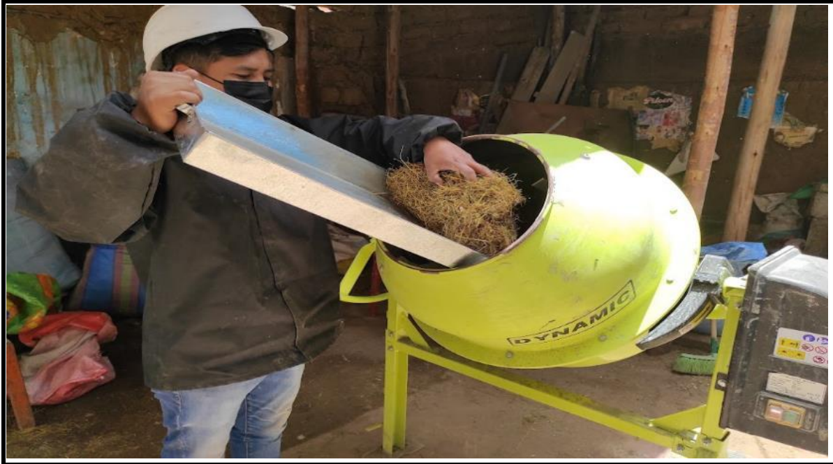
Fotografía 15. VISTA DEL MEZCLADO PARA LA ELABORACION DEL BLOQUE
