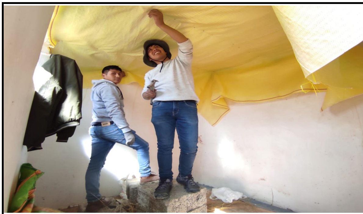
Fotografía 60. VISTA DE LA COLOCACION DE CIELO RASO
