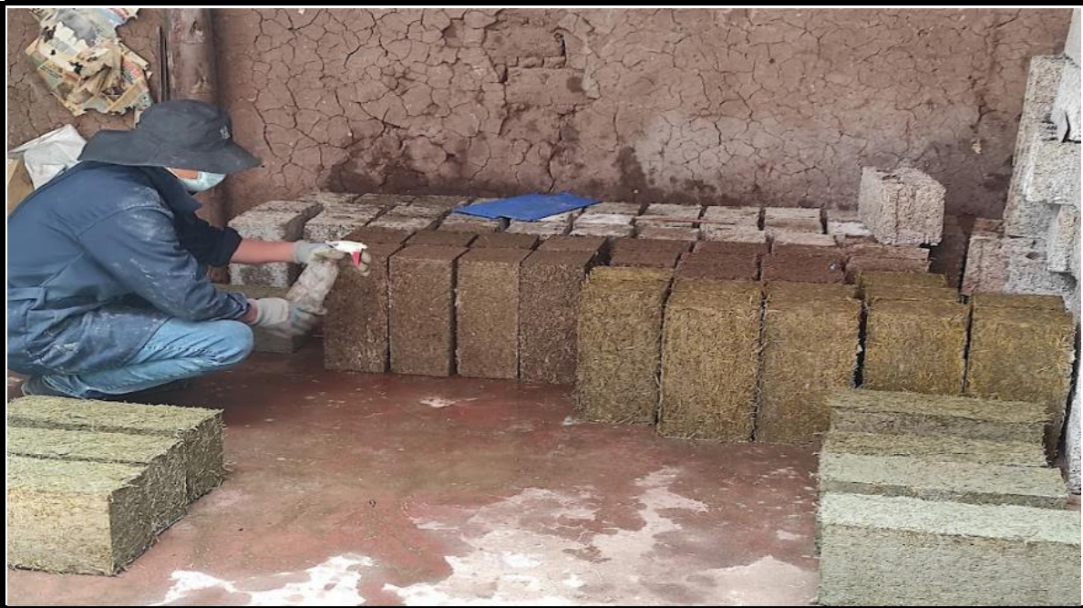
Fotografía 23. VISTA DEL CURADO DE LOS BLOQUES
