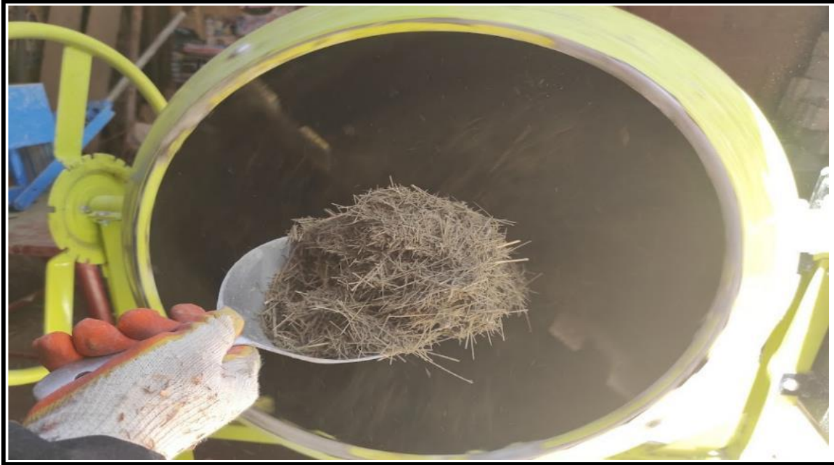
Fotografía 19. VISTA DE LA MEZCLA DEL BLOQUE
