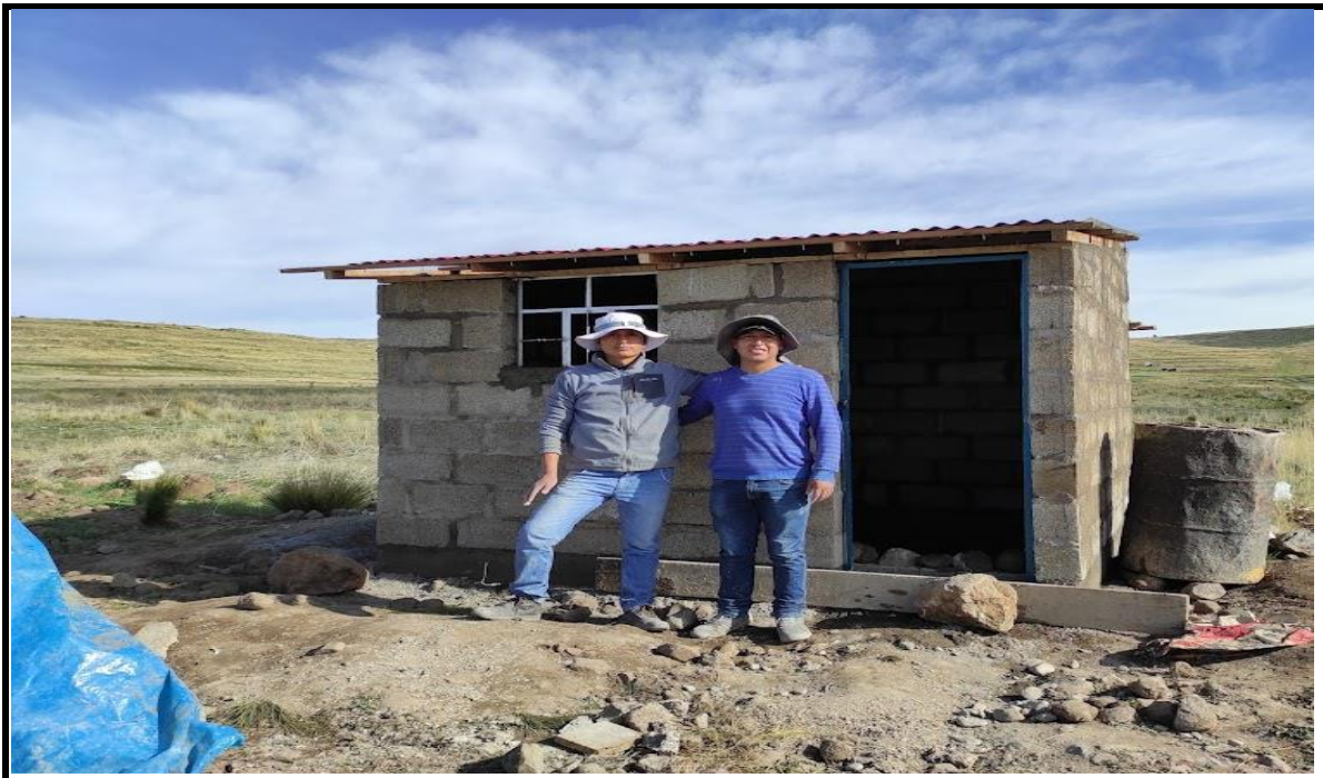
Fotografía 54. VISTA DE LA VIVIENDA PROTOTIPO
