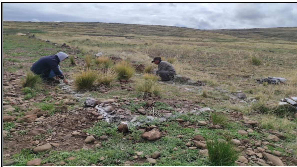
Fotografía 45. VISTA DEL TRAZO Y REPLANTEO PARA LA VIVIENDA PROTOTIPO
