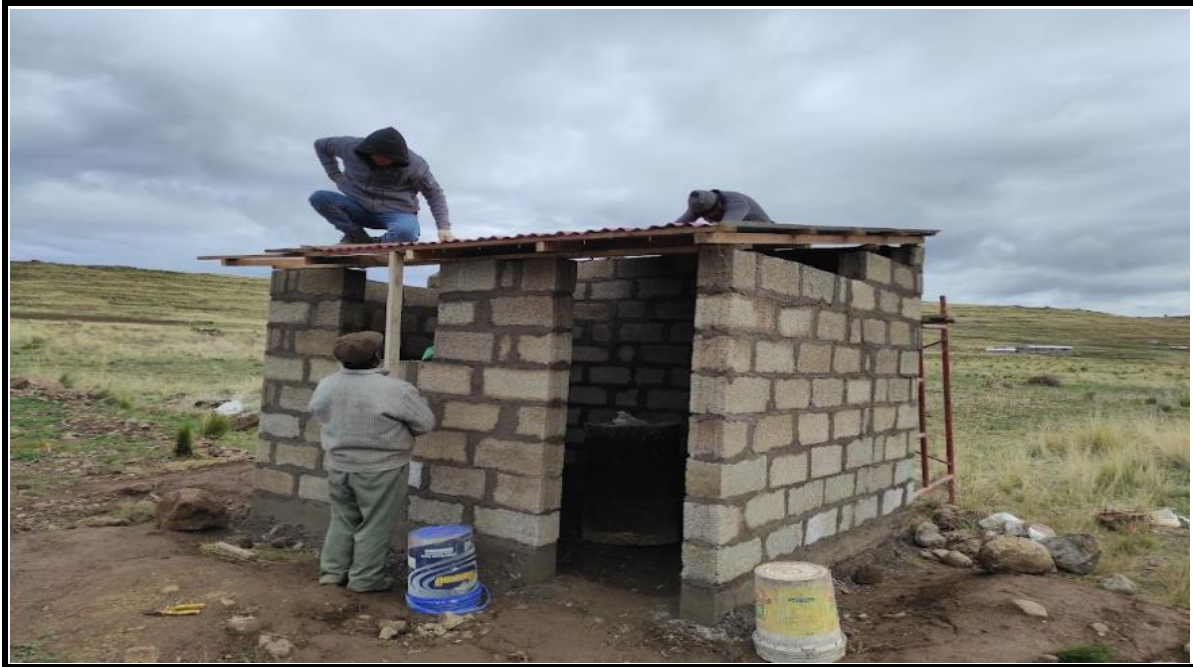
Fotografía 51. VISTA DEL TECHADO CON CALAMINA
