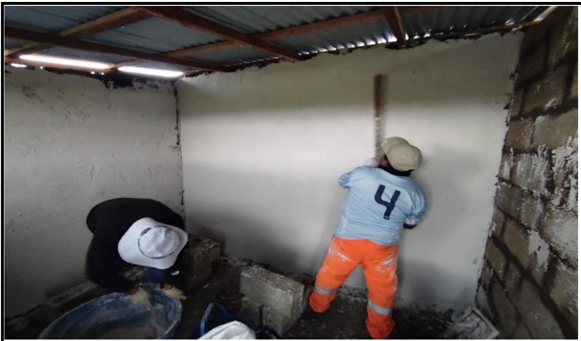
Fotografía 56. VISTA DEL NIVELADO DEL ENLUCIDO
