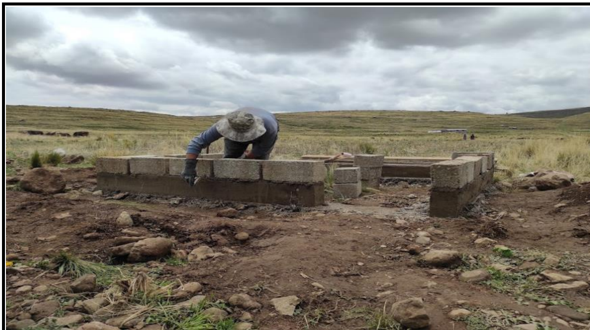
Fotografía 49. VISTA DE LA PRIMERA HILADA CON BLOQUES DE CEMENTO ADICIONADO CON STIPA ICHU Fecha: 04/09/2021
