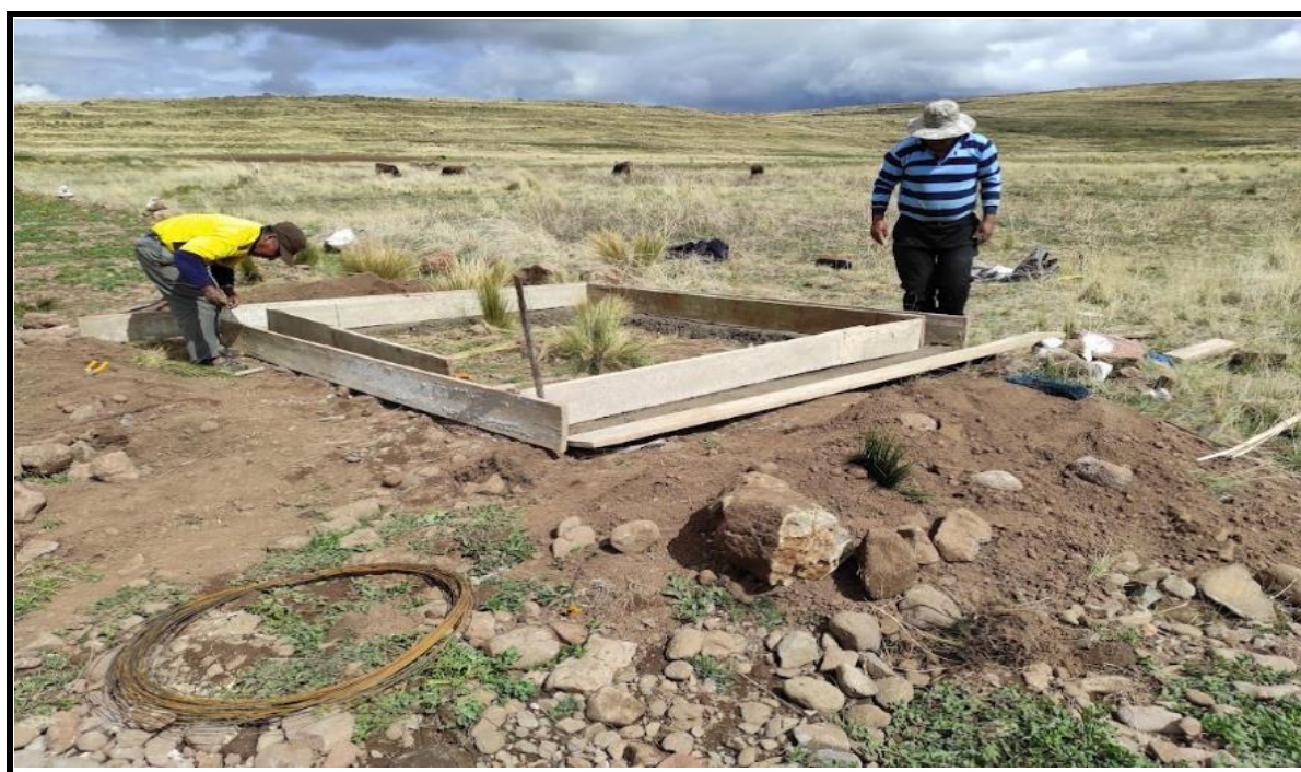
Fotografía 48. VISTA DEL ENCOFRADO DEL SOBRECIMIENTO
