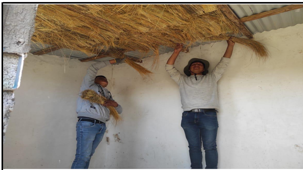
Fotografía 59. VISTA DE LA ARMADO PARA COLOCACION DE CIELO RASO
