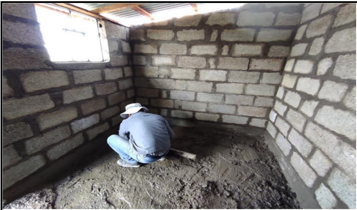
Fotografía 52. DEL VACIADO DEL PISO DE E=2.5 CM
