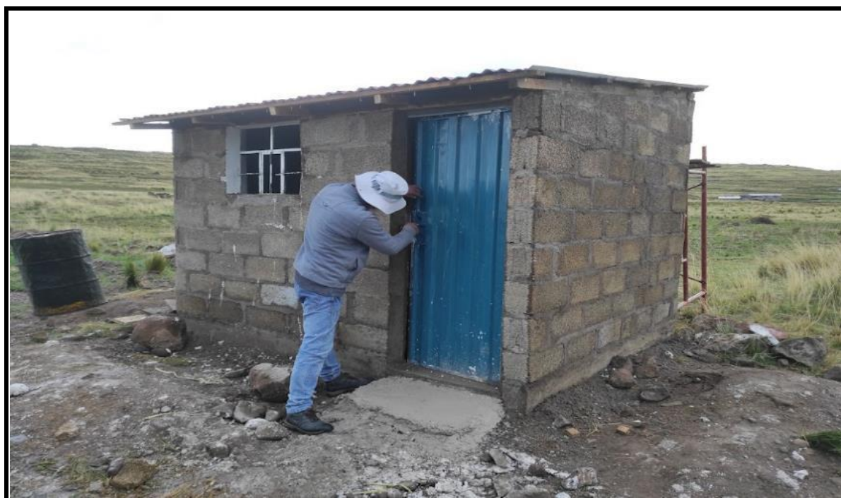
Fotografía 58. VISTA DEL COLOCADO DE LA VENTANA Y PUERTA
