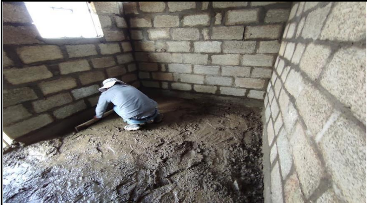
Fotografía 53. VISTA DEL NIVELADO DEL PISO
