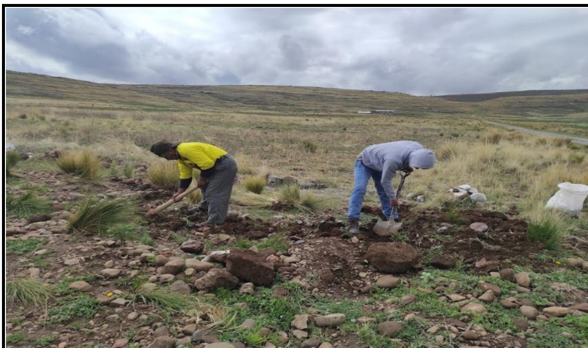
Fotografía 46 . VISTA DE LA EXCAVACION DE ZANJA PARA CIMIENTO CORRIDO
