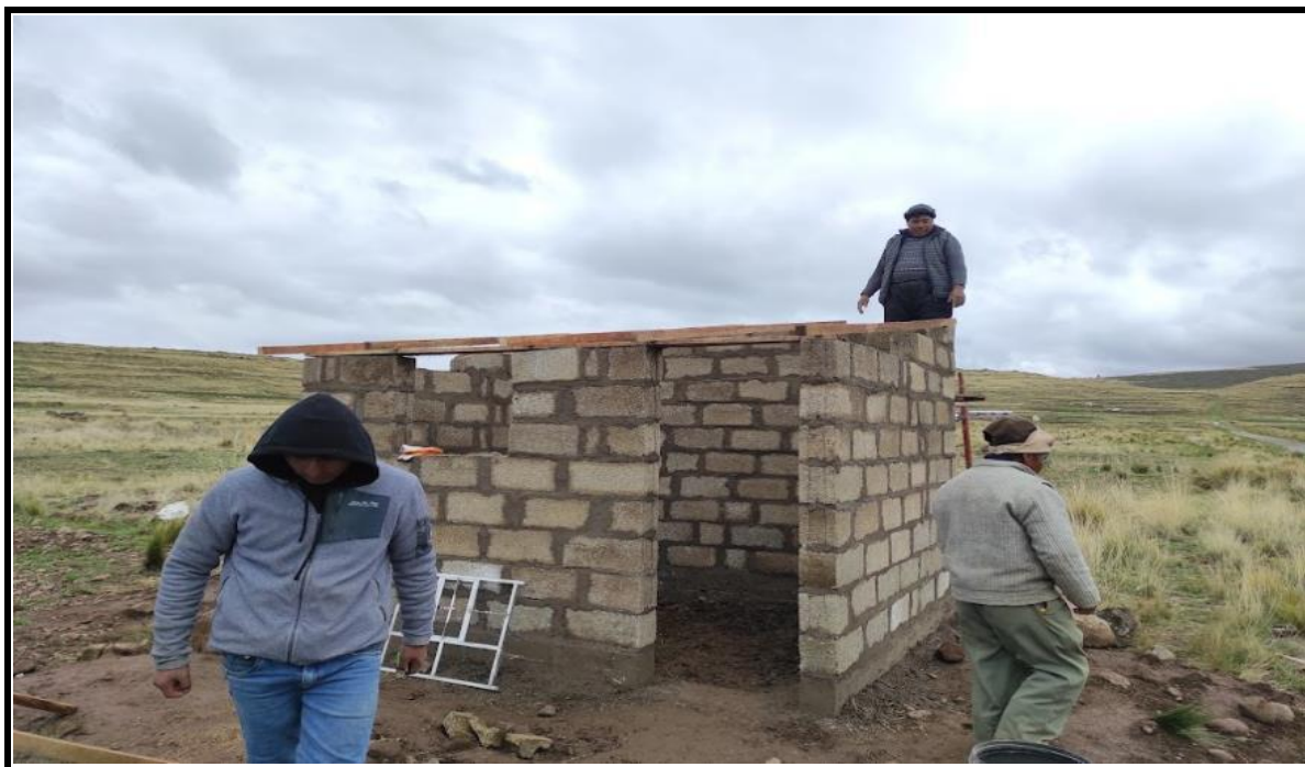
Fotografía 50. VISTA DEL MURO CON BLOQUES DE CEMENTO ADICIONADO CON STIPA ICHU Fecha: 07/09/2021
