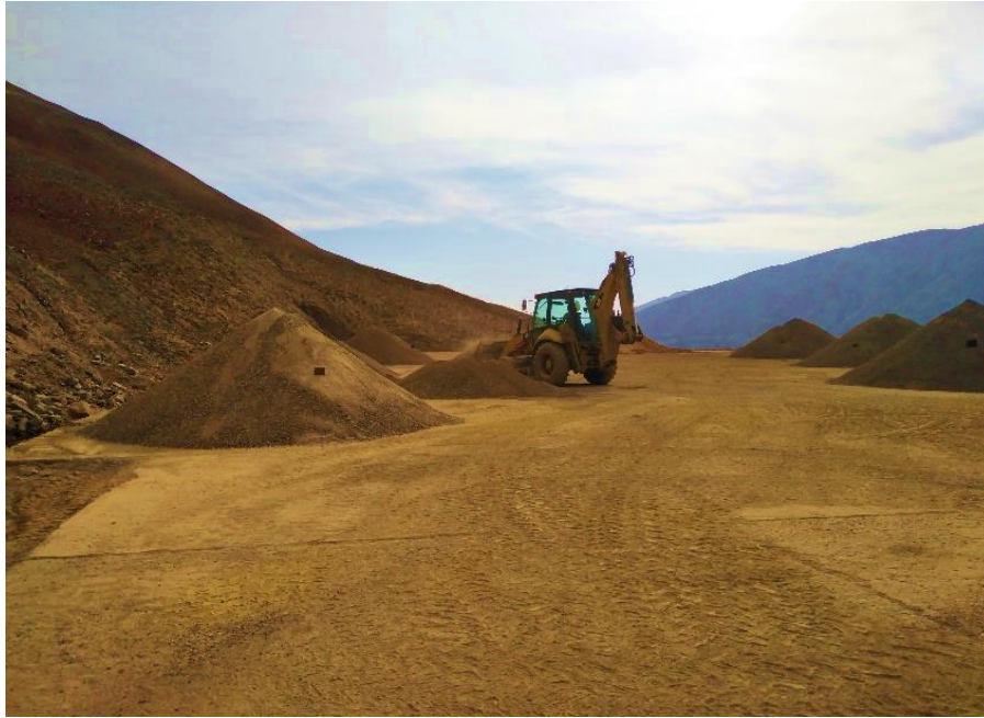
Figura 8. Área de recepción de material
