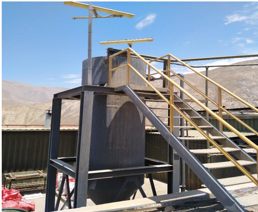
Figura 16. Reactor de 2TN de capacidad
