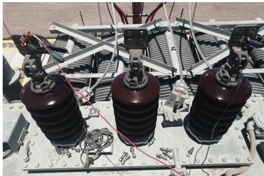
Figura 17: Conexión de cables de prueba del equipo FRANK 101 MEGGER Elaboración propia
