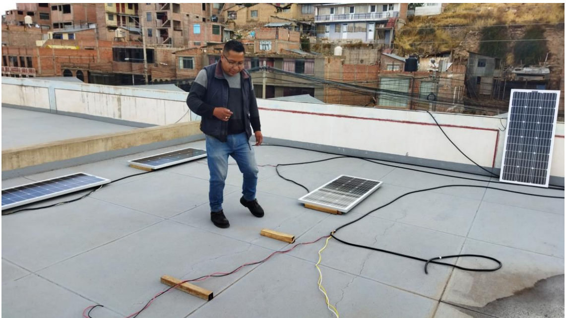
Instalación de unidades experimentales (módulos fotovoltaicos).
