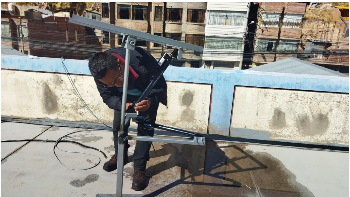
Instalación del seguidor solar.
