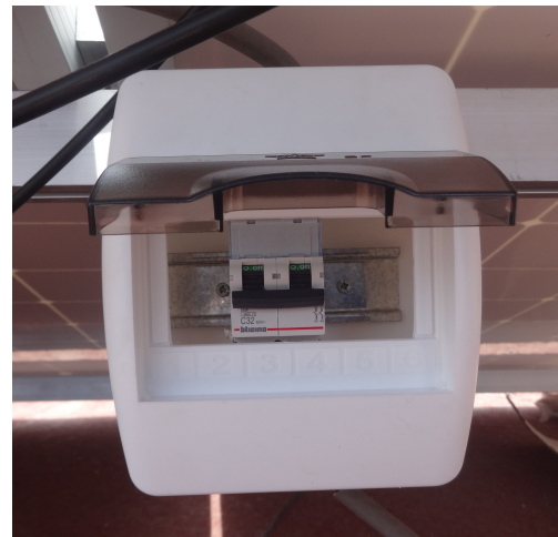
Equipo de Protección a la Salida del Micro Inversor
