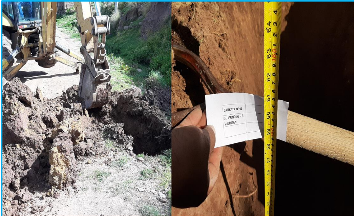
Figura 19. Toma de muestra de suelo natural de la calicata C-3
