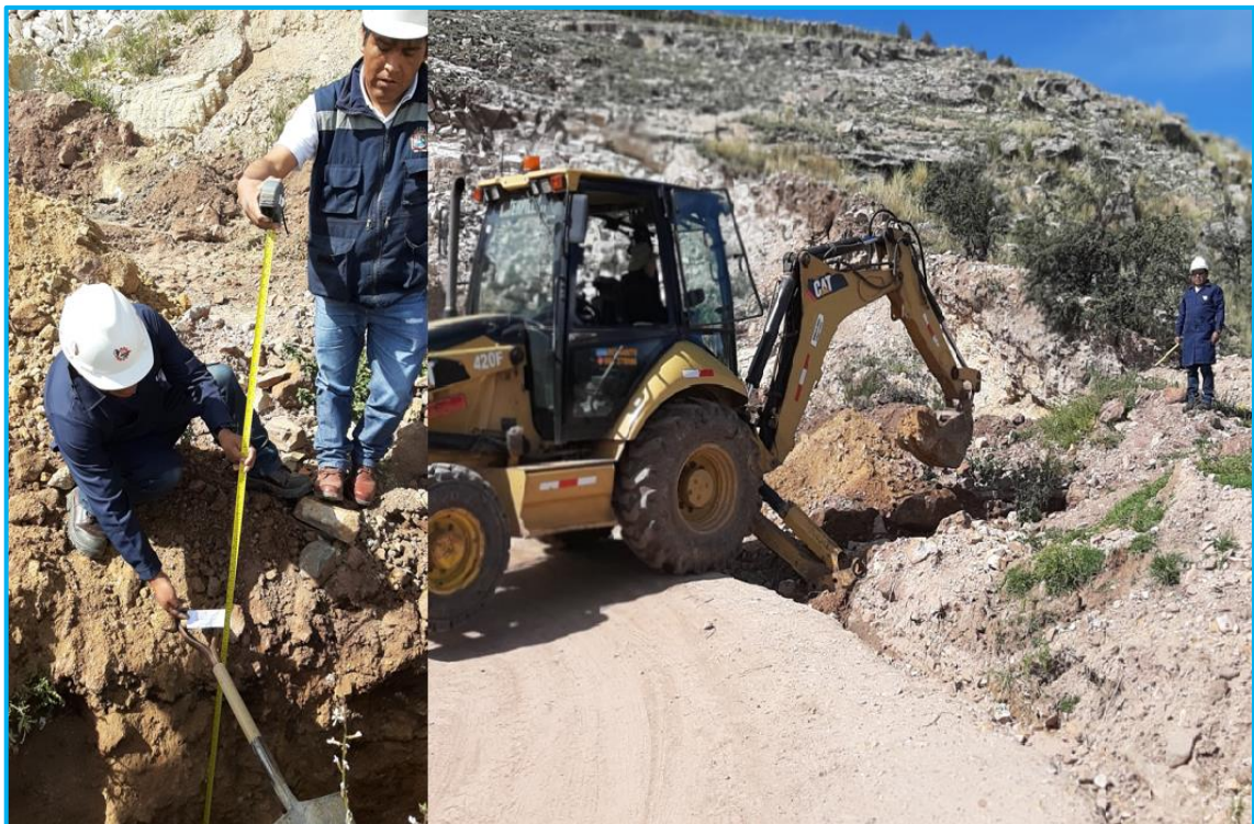
Figura 20. Toma de muestra de suelo natural de la calicata C-4
