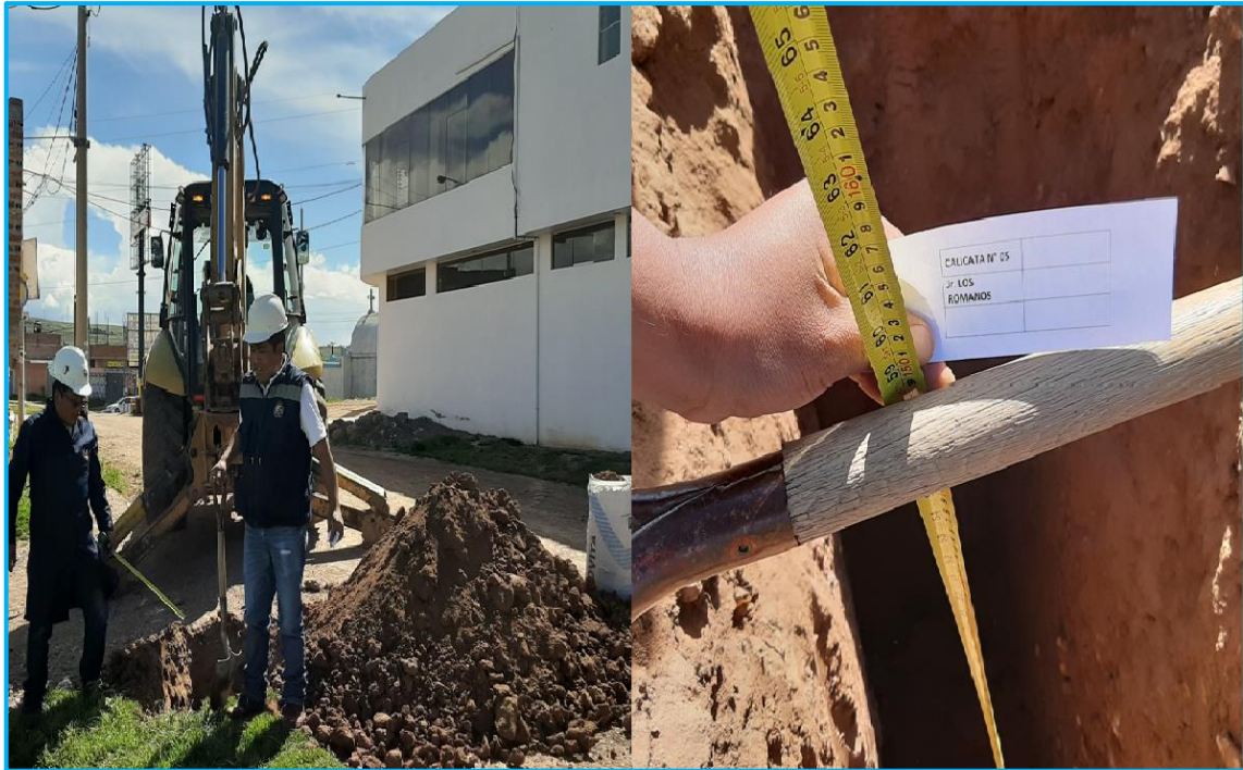
Figura 21. Toma de muestra de suelo natural de la calicata C-5
