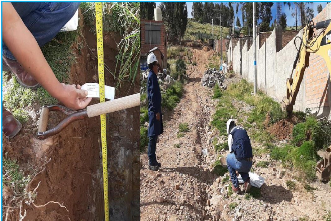
Figura 18. Toma de muestra de suelo natural de la calicata C-2
