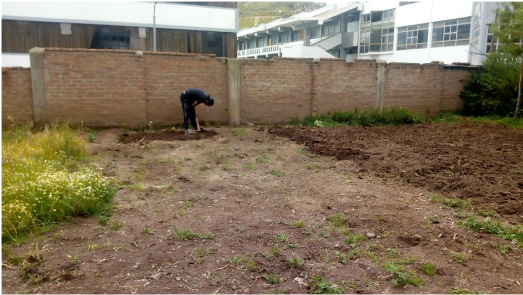
Figura 8. Preparación del terreno.
