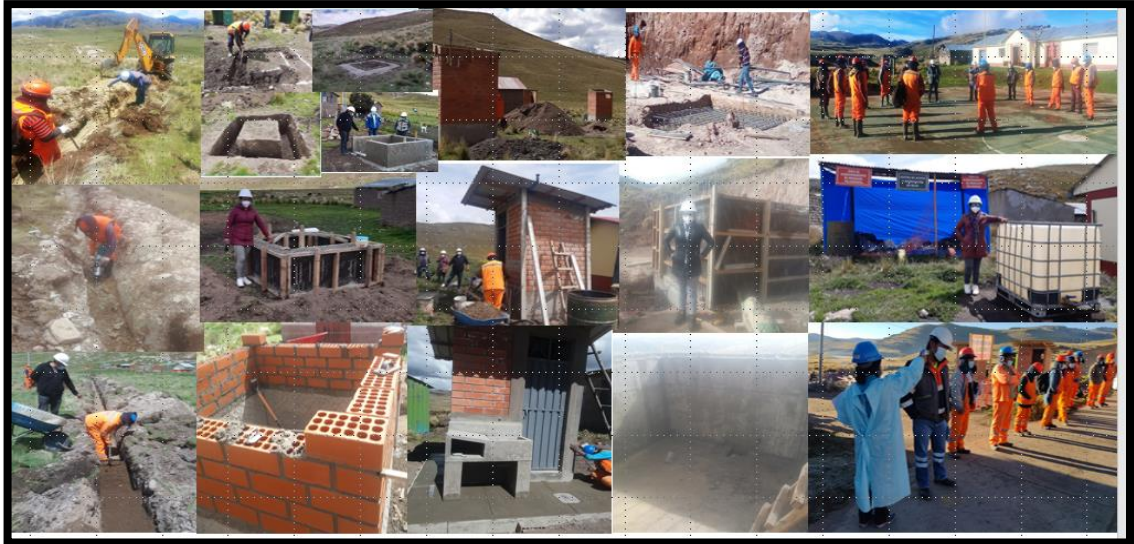
Figura 24. La ejecución de obra de agua potable y saneamiento
