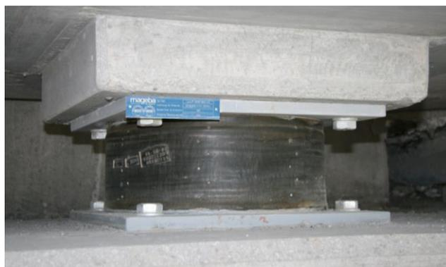
**Figura 15:** Aislador elastoméricos de alto amortiguamiento HDRB
