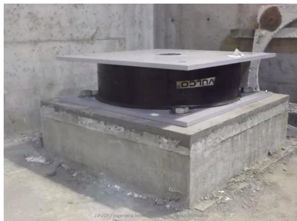
**Figura 5:** Aislador elastomérico instalado en obra
