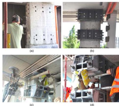
**Figura 22:** Proceso constructivo por el método temporal (a) Perforación de la columna de concreto armado, (b) Instalación de soportes de acero, (c) Incisión de la columna, (d) Instalación de los aisladores sísmicos.
