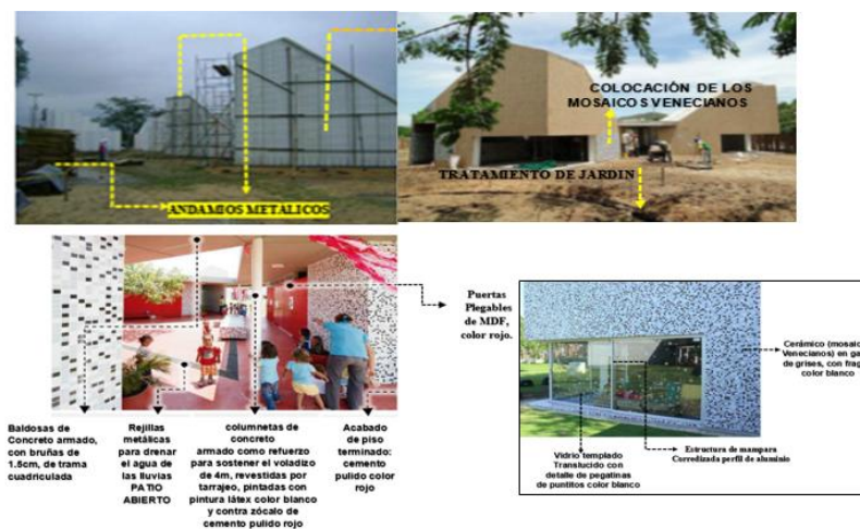
Figura 22. Sistema Constructivo y acabados del Jardín Timayui.
