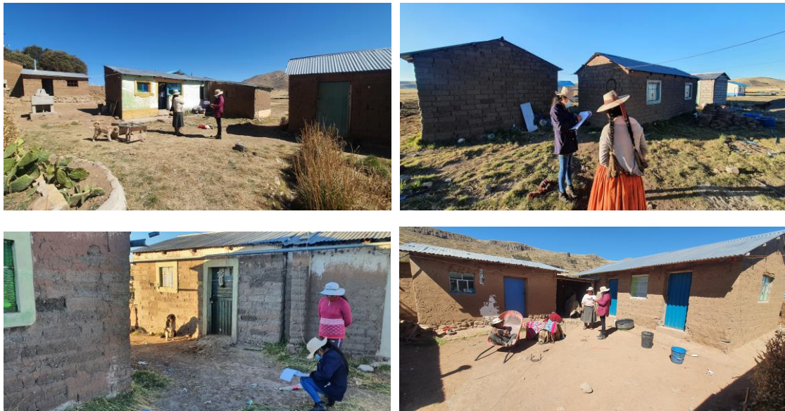
Figura 15. Viviendas rurales con predominancia de construcción de adobe.
