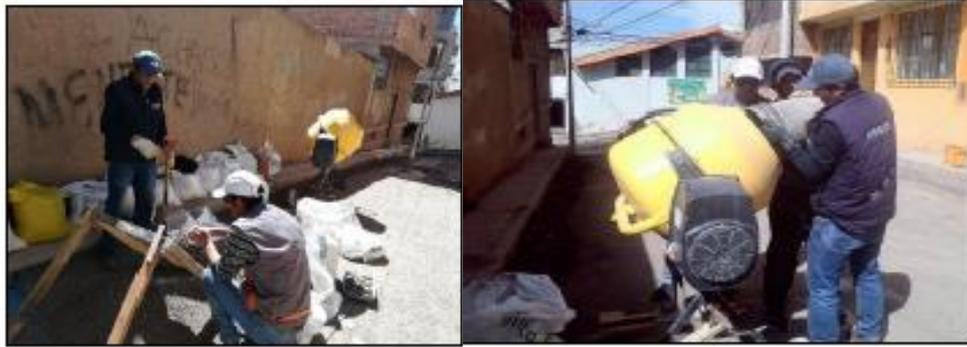
**Figura 12.** Manipulación de componentes y mezclado del concreto
