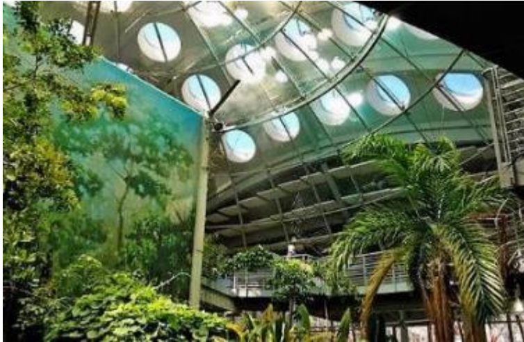
Figura 10. Techo central del complejo educativo
