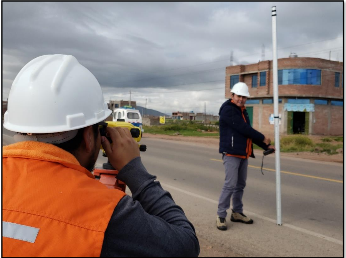
Figura 10: Lectura de datos con nivel de ingeniero
