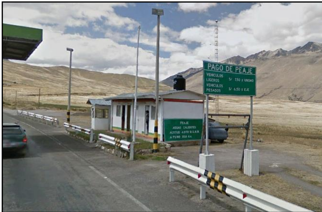
Figura 11: Unidad de peaje Aguas Calientes
