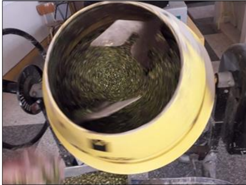
C9. Mezcla de concreto celular con fibra de totora y aditivo incorporador de aire.
