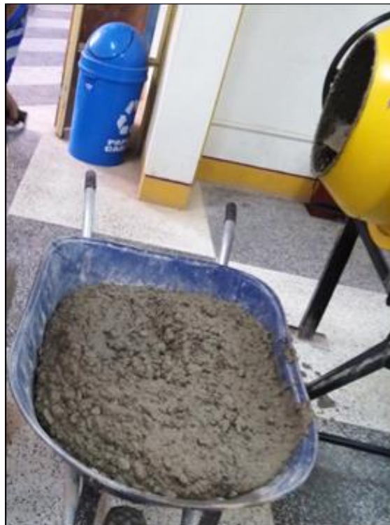
C8. Mezcla de concreto testigo (CCT-0%).
