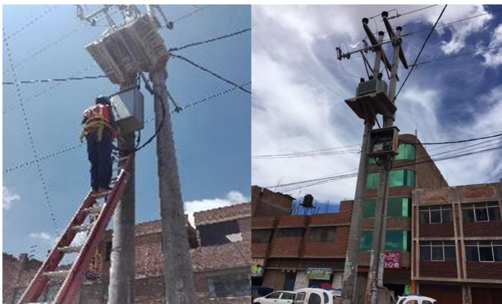
Figura 18. Fotos de la instalación de los equipos del Proyecto Virgen de las Mercedes
