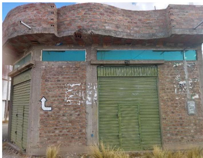
También se realizó el ensayo de Martillo de Schmidt o Ensayo del Índice Esclerométrico la cual obtenida una resistencia de  $130 \text{ kg/cm}^2$  en la mayoría de las columnas.
