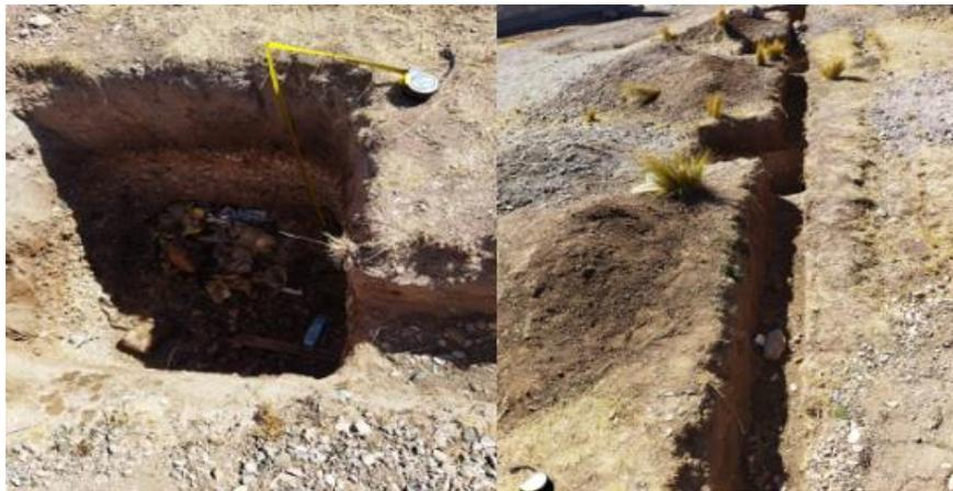
Según la Norma E.050 Suelos y Cimentaciones nos indica que la profundidad de cimentación es definida por el profesional responsable y está condicionada por la estratigrafía del suelo, a cambios de volumen por humedecimiento-secado, hielo deshielo o condiciones particulares de uso de la estructura, no siendo menor de 0,80 metros en cualquier tipo de cimentación de elementos portantes o no portantes no arriostrados lateralmente.
