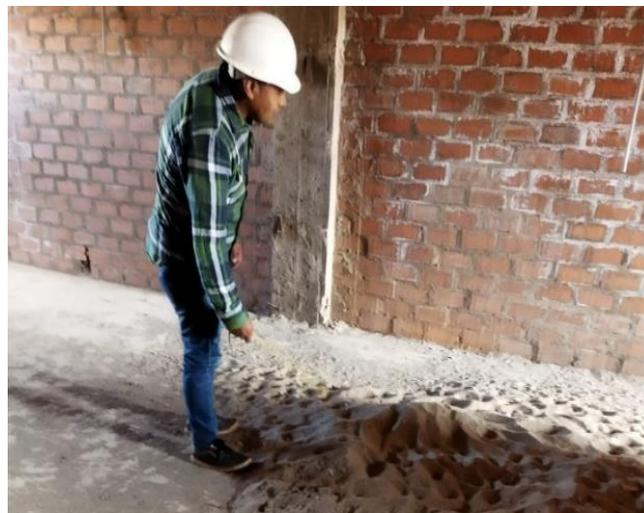
Por lo general el espesor de las juntas tanto horizontales como verticales es de 2cm a 3cm. Pero en la norma de la E.070 de Albañilería nos indica que el espesor de las juntas de mortero será como mínimo 10 mm (1cm) y el espesor máximo será 15 mm (1.5 cm).
