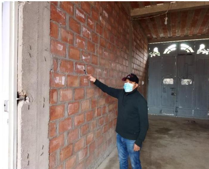
Por otro parte, los muros no portantes están constituidas por ladrillos panderetas mecanizadas como se muestra en la figura.
