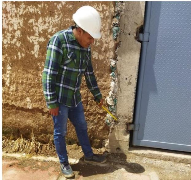
En algunos casos se observa también columnas cortas de 20cm en la parte superior del muro. Esta forma de construcción tiene un “efecto de estas columnas cortas, trae como consecuencia una modificación local de la distribución de tensiones y deformaciones del miembro estructural afectado” (Beauperthuy y Urich, 2011).
