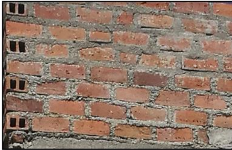
Figura 44. Muro de ladrillos Pandereta artesanal, de f'm = 35 \text{ Kg/cm}^2 .
