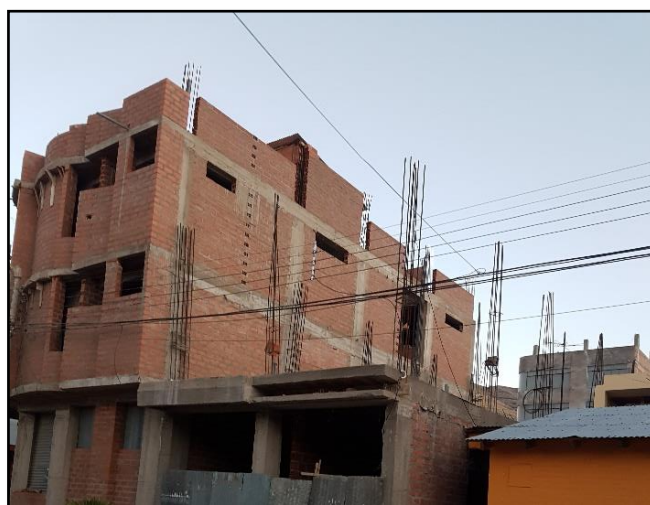
Figura 59: parapetos no arriostrados
