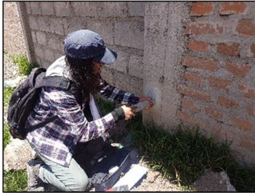
Figura 29. Toma de resistencia a columna
