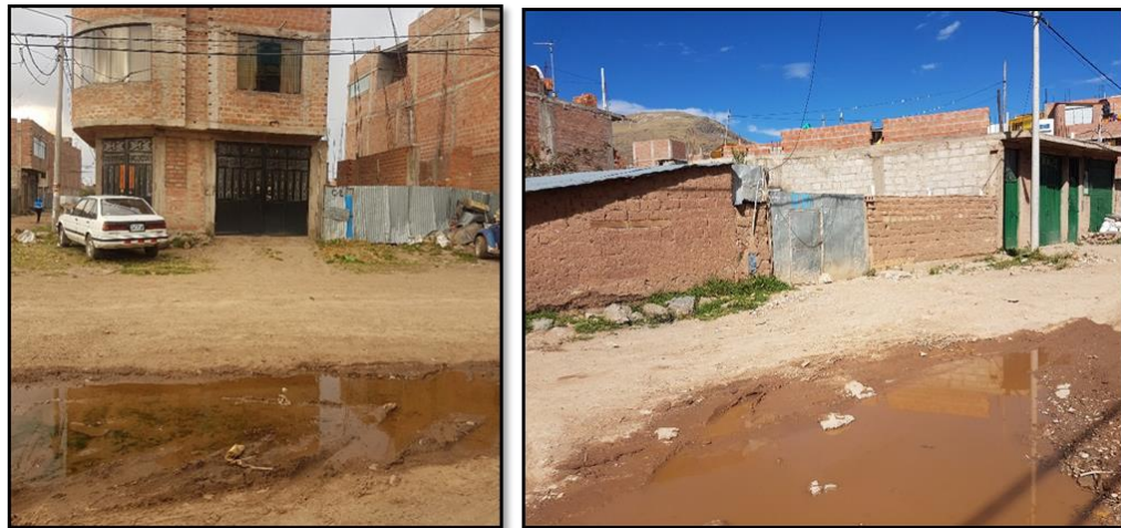
Figura 20: Charcos de agua a causa de las precipitaciones pluviales
