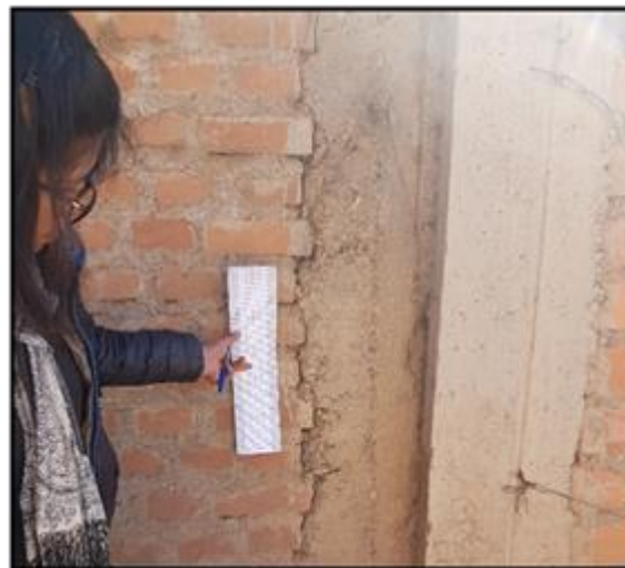
Figura 27. Junta de más de 2.5 mm.
