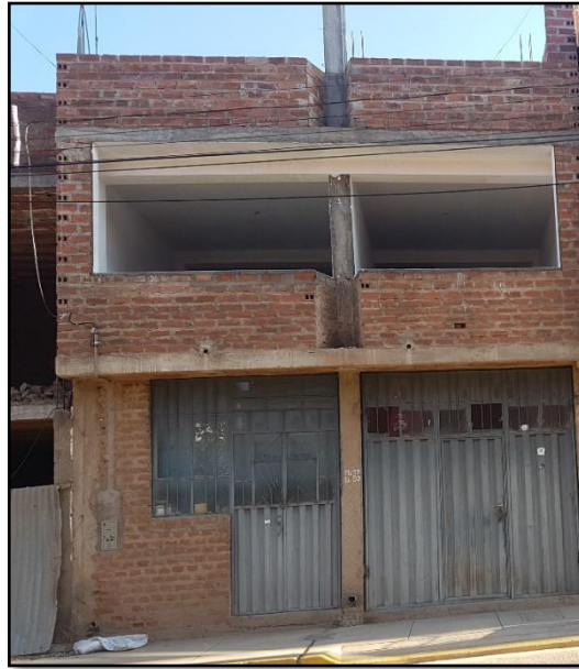
Figura 58: Se observa muros en un solo eje.
